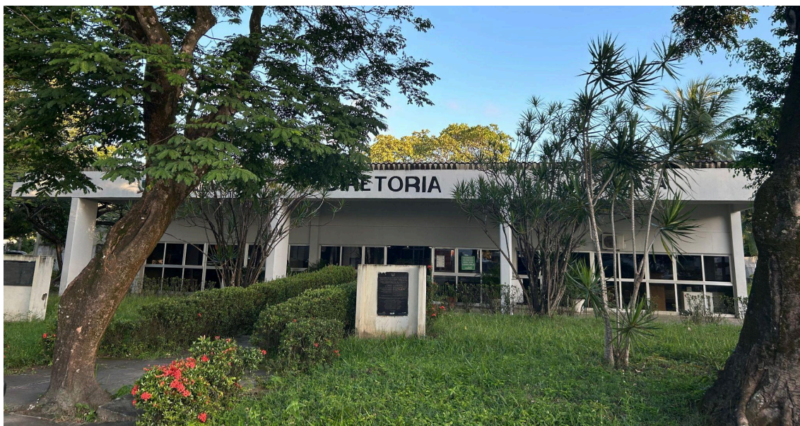
Figura 53 - Fotografia do prédio administrativo, 2024.
