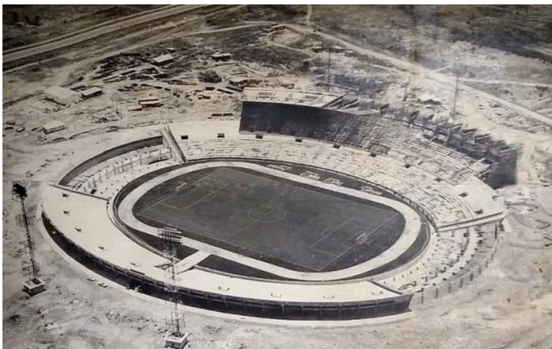
Figura 18 - Vista aérea da construção do Estádio Ministro José Américo de Almeida, 1971.
