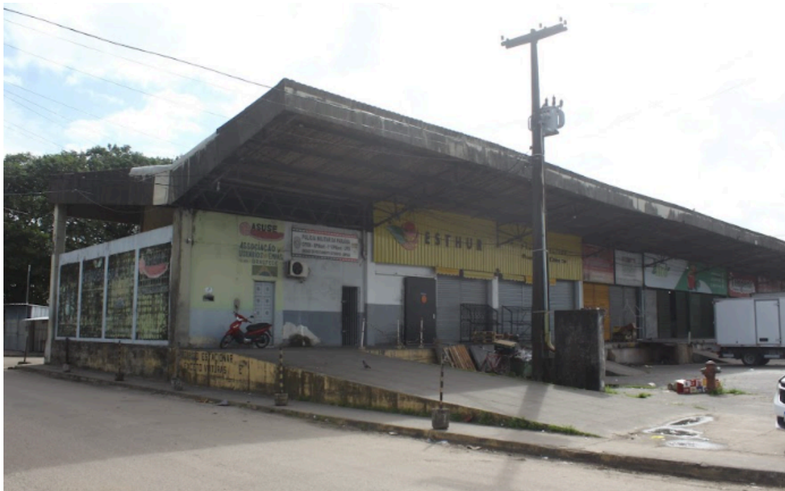
Figura 43 - Fotografia do Galpão 01.
