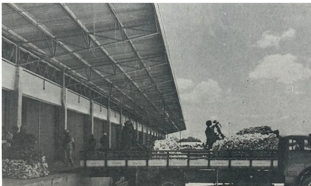
Figura 32 - Fotografia da construção dos galpões da Central de Abastecimento, 1974.
