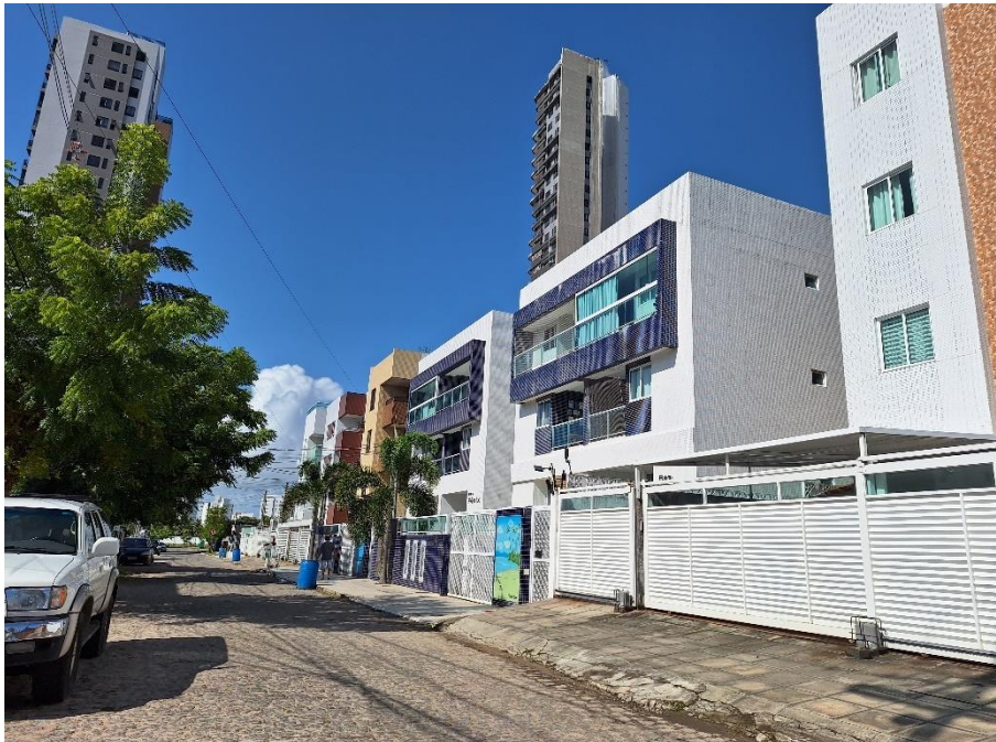
Figura 34 – Edifícios residenciais e lote em construção
