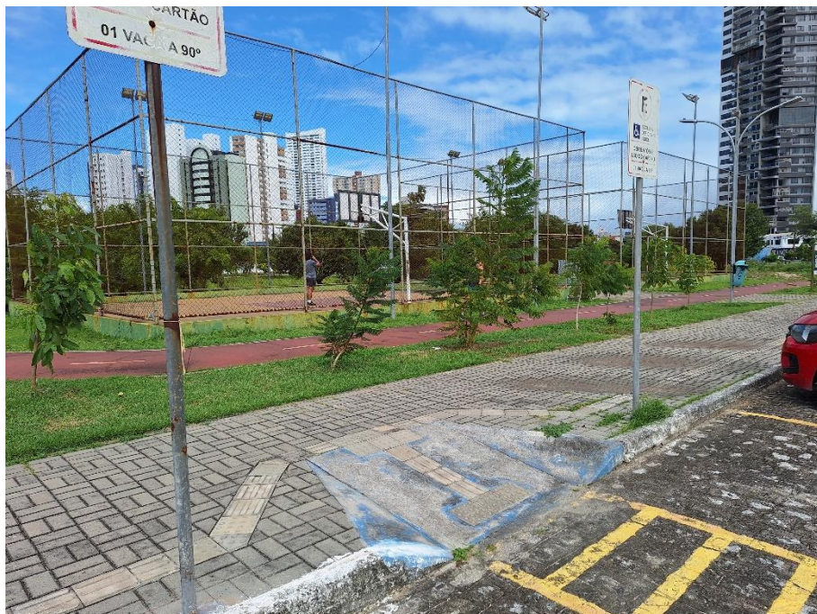
Figura 42 – Piso tátil e rampas em estacionamento
