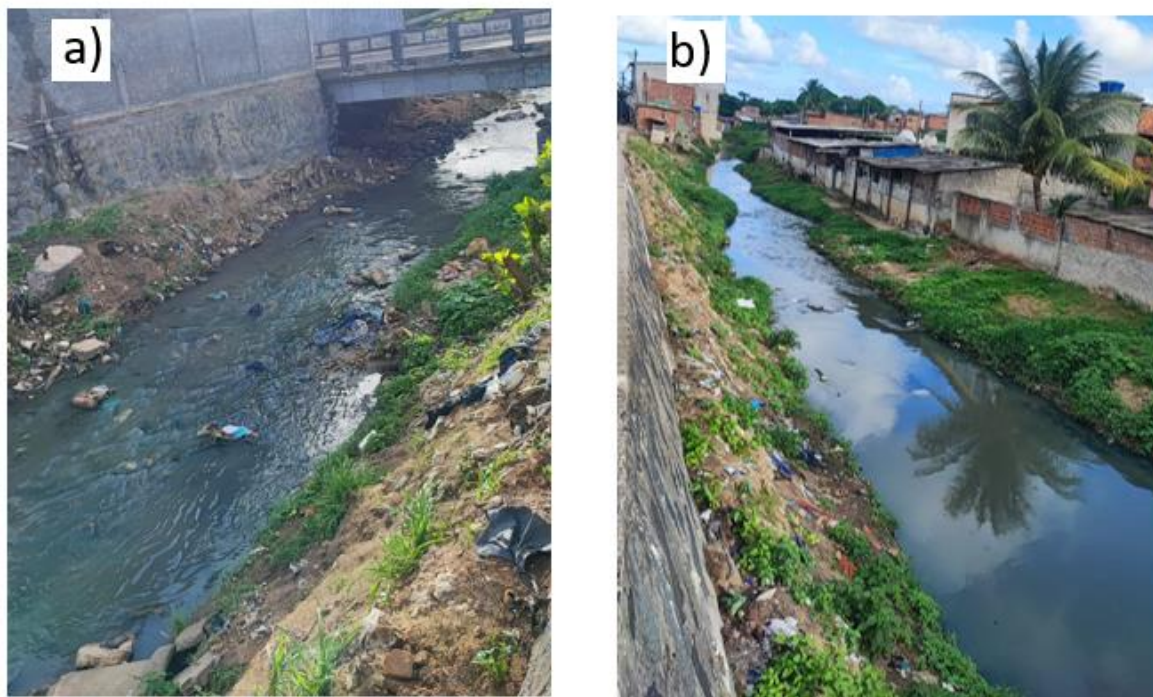
Figura 3- Situação atual do rio Morno- a) Presença de resíduos sólidos no leito do rio; b) ocupações irregulares nas margens do rio
