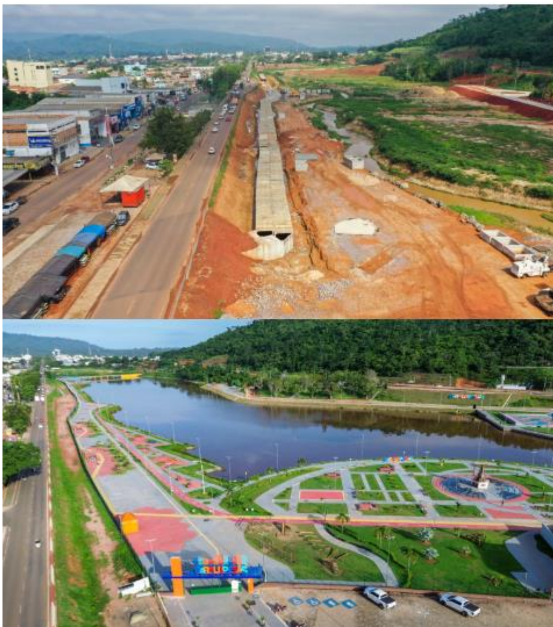
Figura 39 - Obras de infraestrutura e construção do Complexo turístico de Parauapebas
