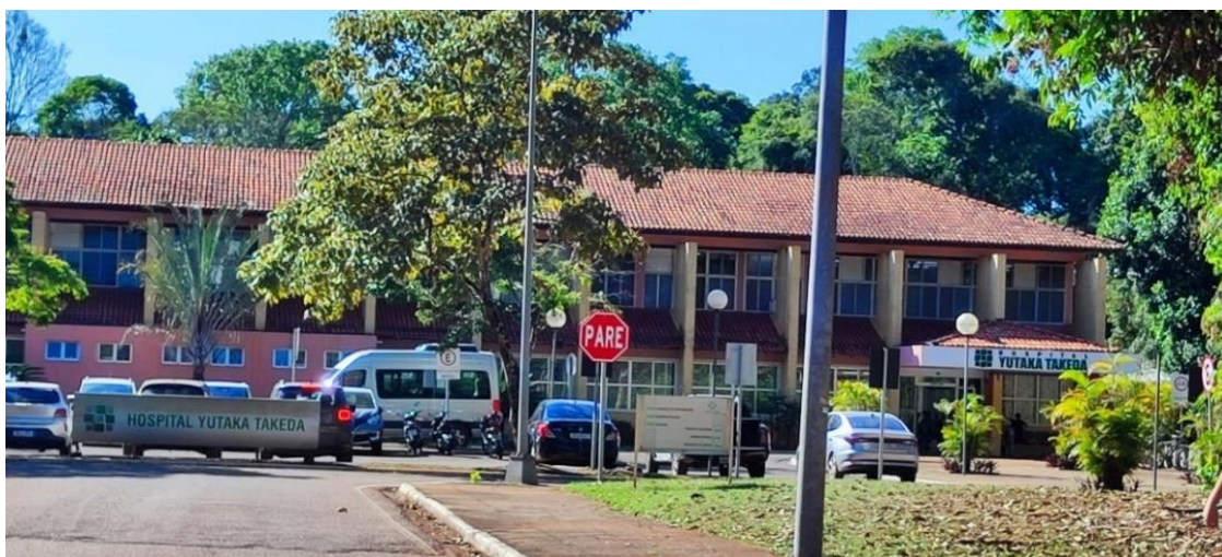
Figura 7 - Hospital Yutaka Takeda, localizado no Núcleo urbano de Carajás
