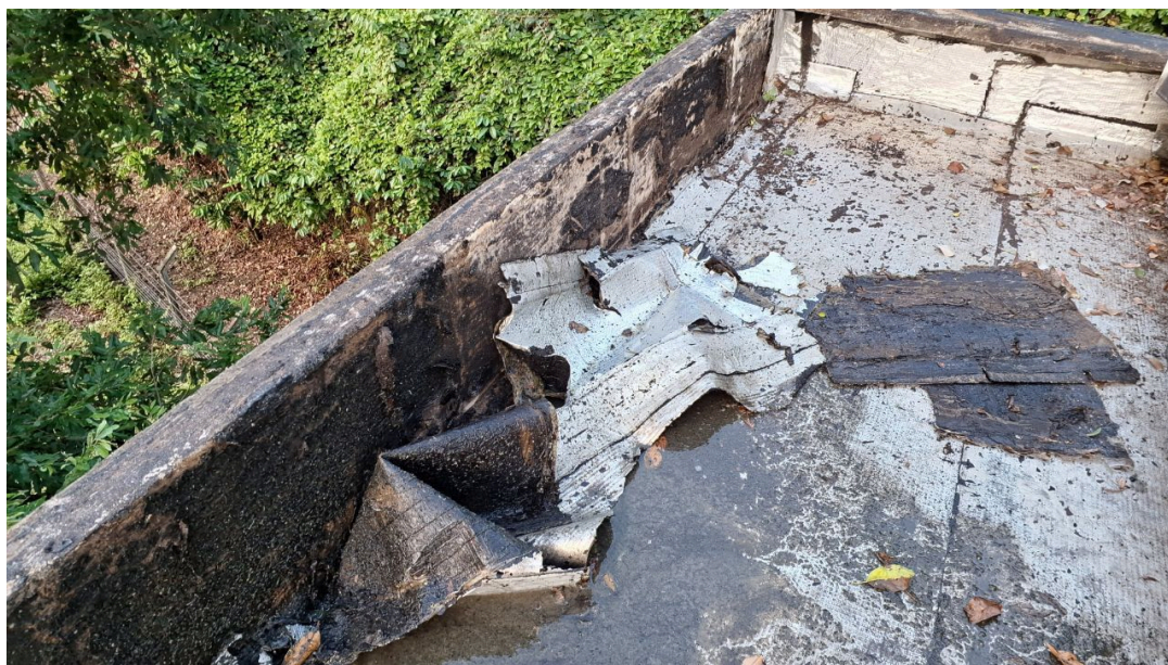
Figura 19. Remoção da impermeabilização da cobertura das salas do CT – Bloco H
