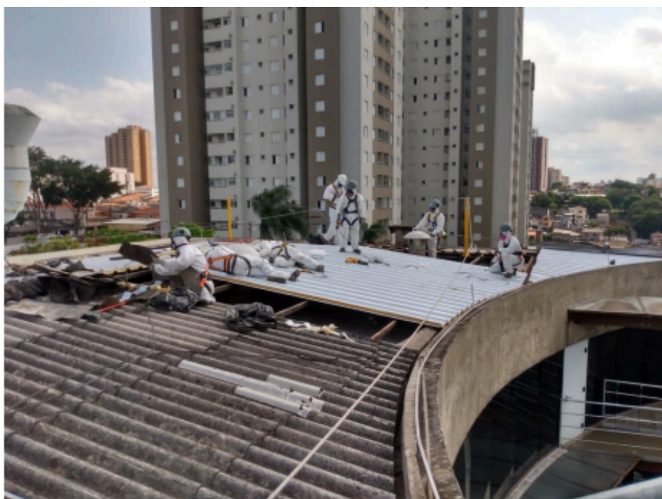
Figura 7. Trabalhadores fazendo a retirada do MCA usando EPIs para remoção do MCA e EPIs de trabalho em altura
