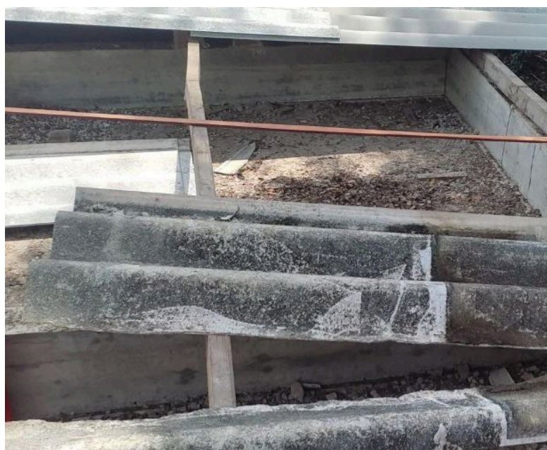
Figura 17. Cobertura do prédio do STI
