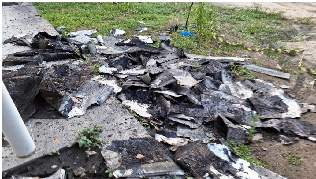
Figura 20. Mantas asfálticas aluminizadas removidas no CT – Bloco H, antes do acondicionamento
