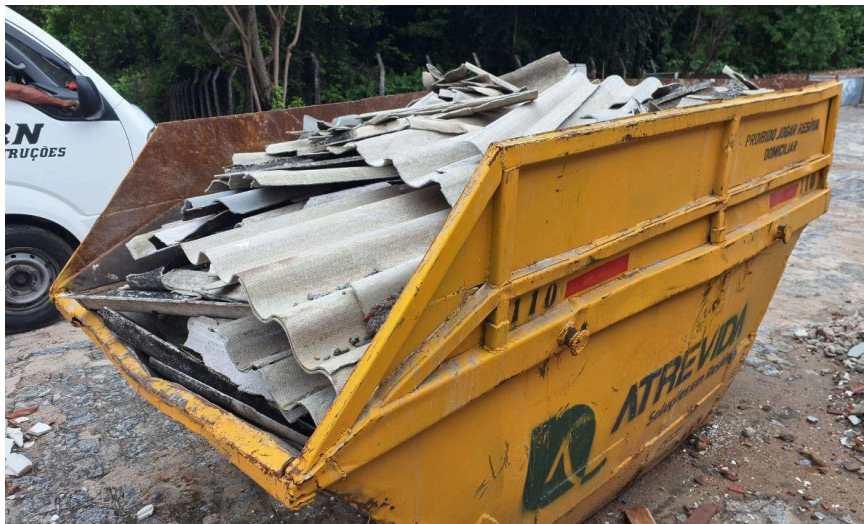
Figura 13. Caçamba no CCS contendo Telhas de Amianto
