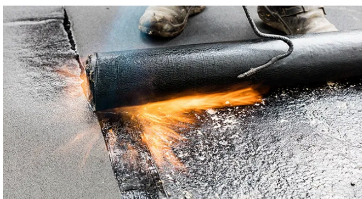
Figura 10. Aplicação de manta asfáltica aluminizada com maçarico
