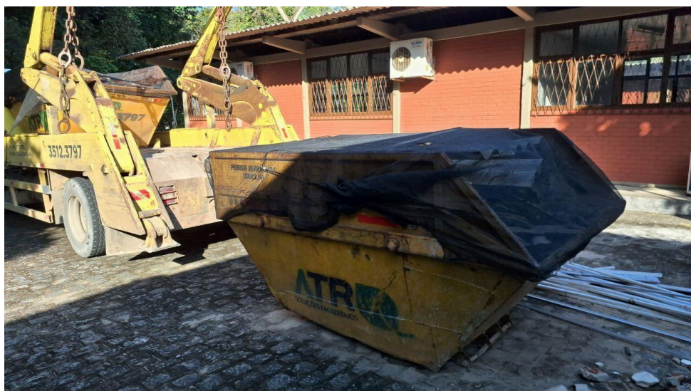
Figura 14. Remoção de caçamba na Central de Aulas contendo Telhas de Amianto
