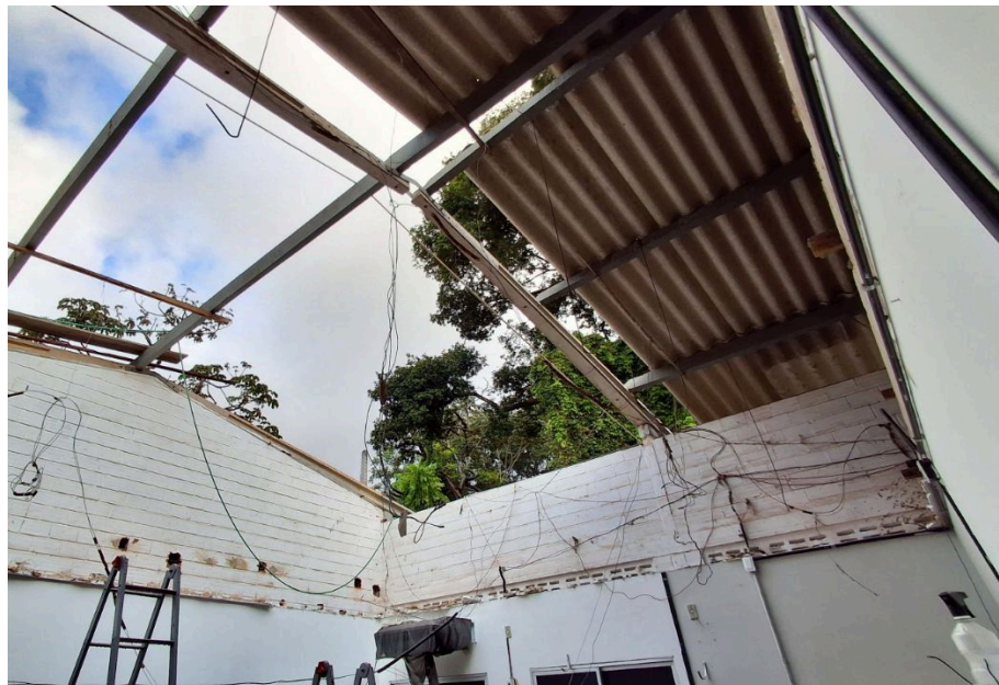
Figura 18. Cobertura das salas CTN 105 e 106, localizadas no LAMAB
