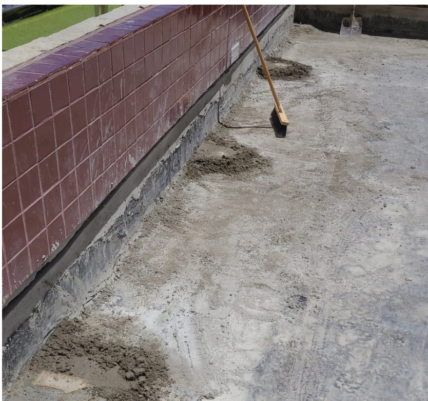
Figura 30 – Execução da proteção mecânica sem camada separadora
