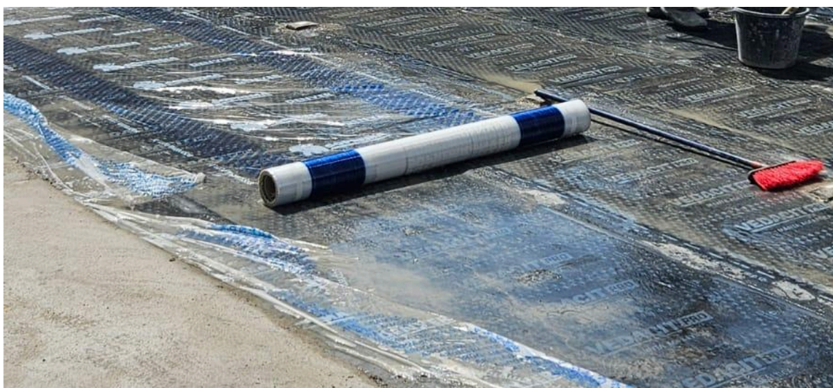
Figura 31 – Aplicação da camada separadora acima da manta asfáltica
