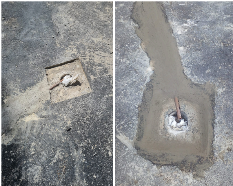
Figura 20 - Passagem de tubulações sob a regularização: a) Execução do embutimento no piso de regularização em direção aos coletores e c) regularização das arestas
