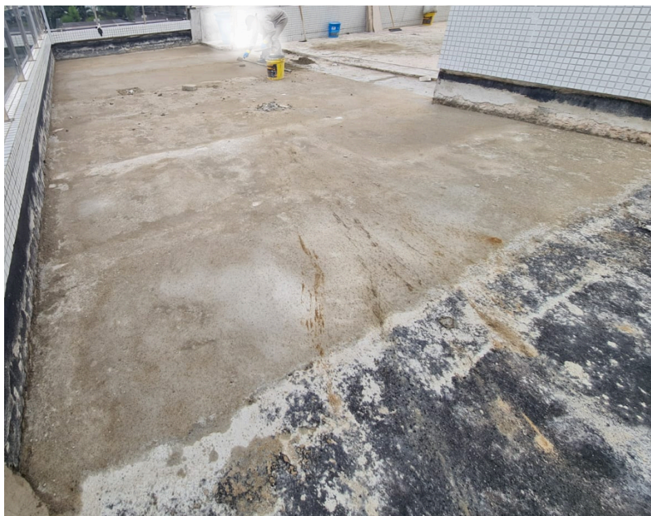
Figura 16 - Substrato com caimentos corrigidos.
