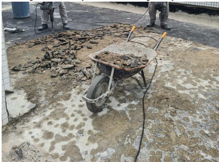
Figura 14 - Demolição da camada de regularização nova.
