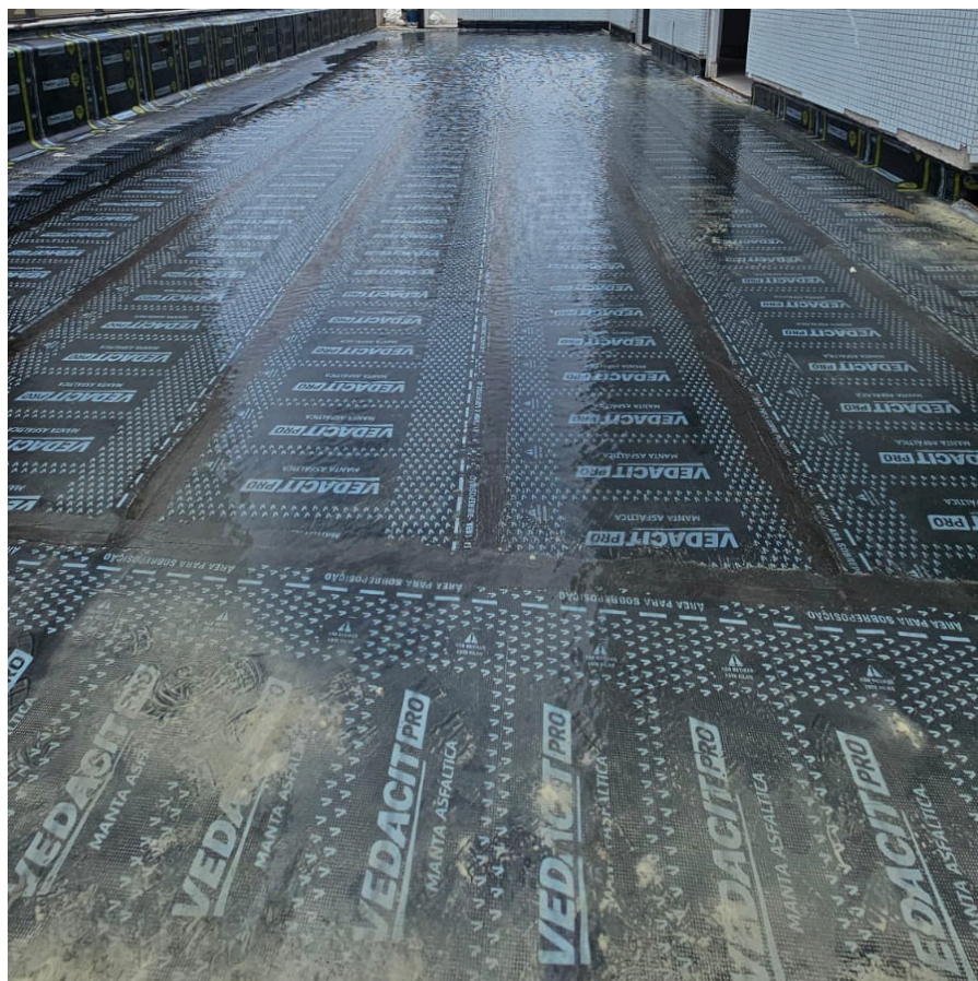
Figura 29 - Teste de estanqueidade
