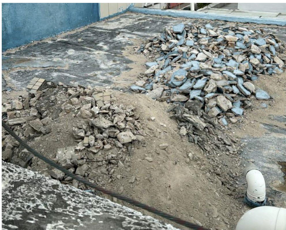
Figura 4 - Execução da demolição do piso de proteção mecânica
