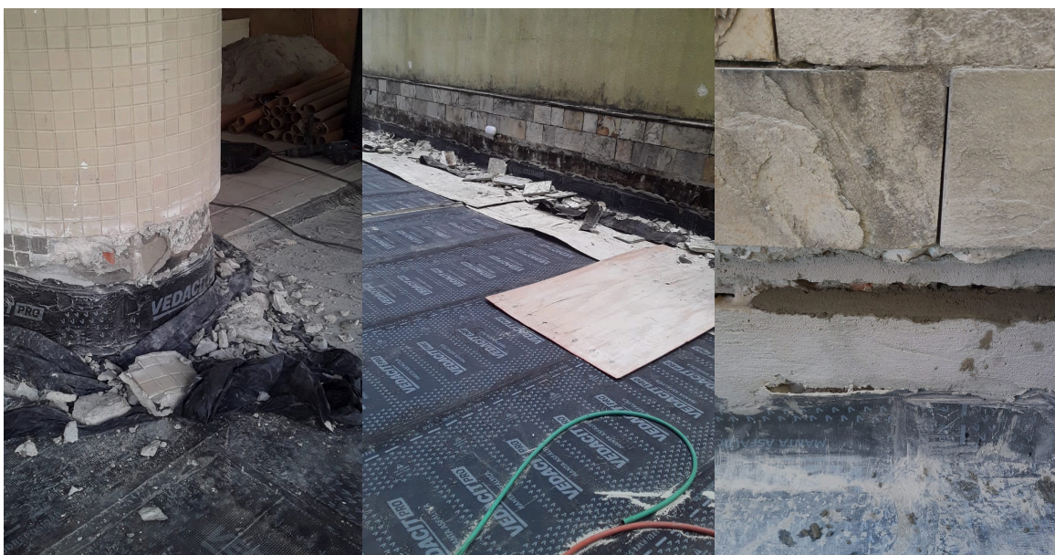
Figura 9 – Demolição do rodapé de: (a) pilares; (b) alvenaria de vedação; e (c) execução da regularização do corte.
