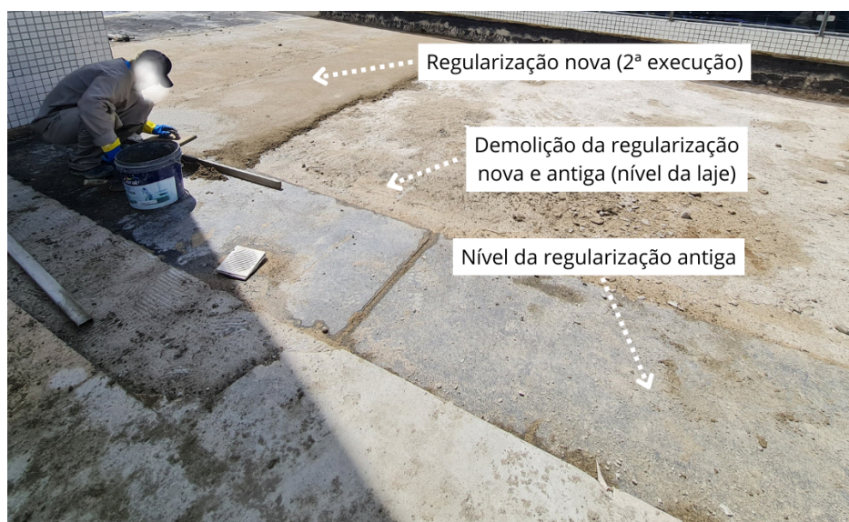
Figura 15 - Execução da regularização pela segunda vez com correção dos caimentos
