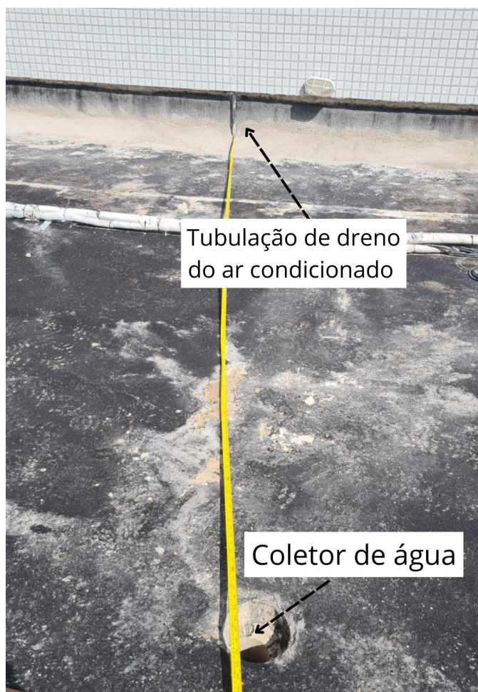
Figura 19 - Tubulação de dreno a ser feita executado o embutimento no piso
