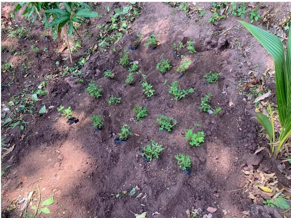
Figura 52 – Implantação inicial da vegetação no talude.
