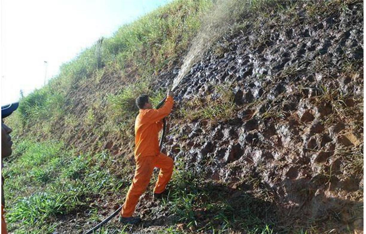
Figura 29 – Demonstração de aplicação de hidrosseadura em talude de corte.
