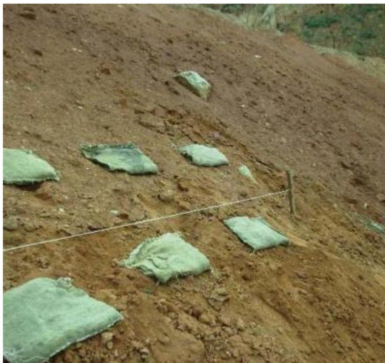
Figura 25 – Recobrimento do talude com sacos de aniagem.
