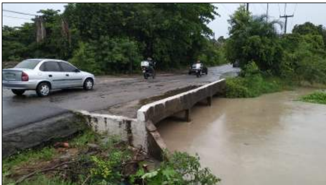
Figura 18 – Ponte sobre o Rio Cuiá
