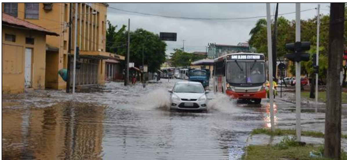
Figura 11 – Representação de um alagamento urbano, no bairro do Varadouro, próximo à estação ferroviária no município de João Pessoa – PB
