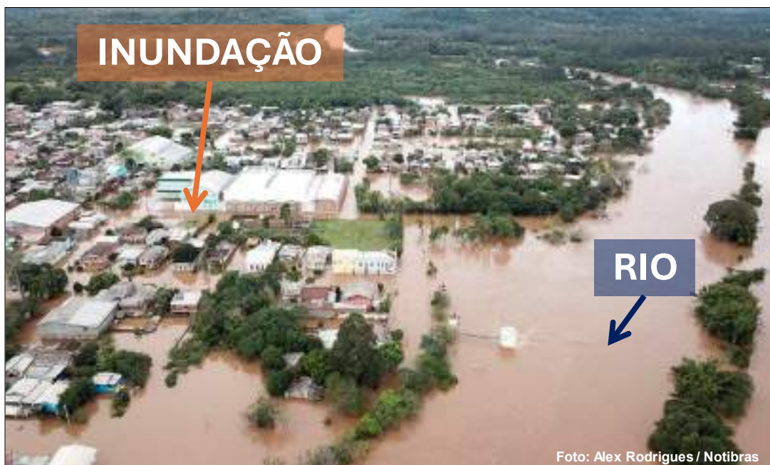
Figura 9 – Inundação na Bacia Hidrográfica do Rio Caí, RS
