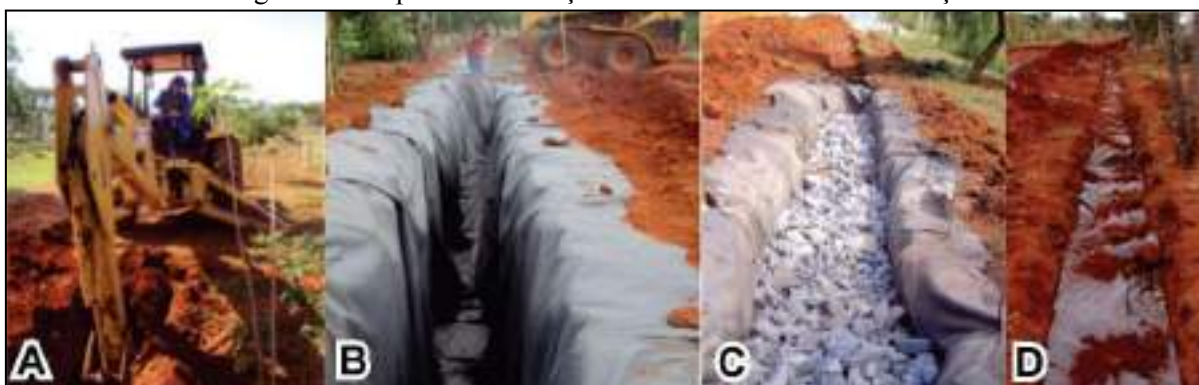
Figura 11: Etapas de construção de uma trincheira de infiltração
