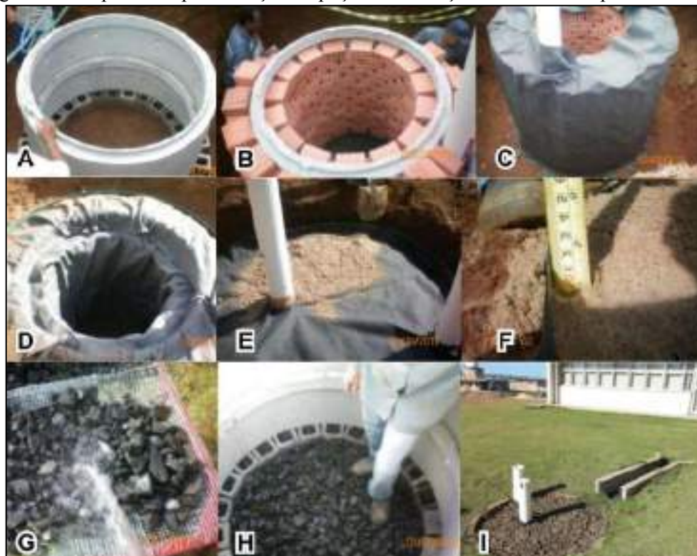
Figura 09: Etapas de implementação do poço de infiltração dentro do campus da UFSCar
