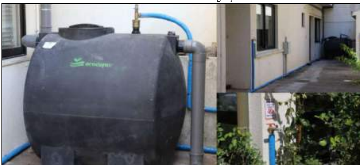
Figura 05: Sistema de aproveitamento de água já em funcionamento em residência de estudantes do Instituto Politécnico de Bragança.
