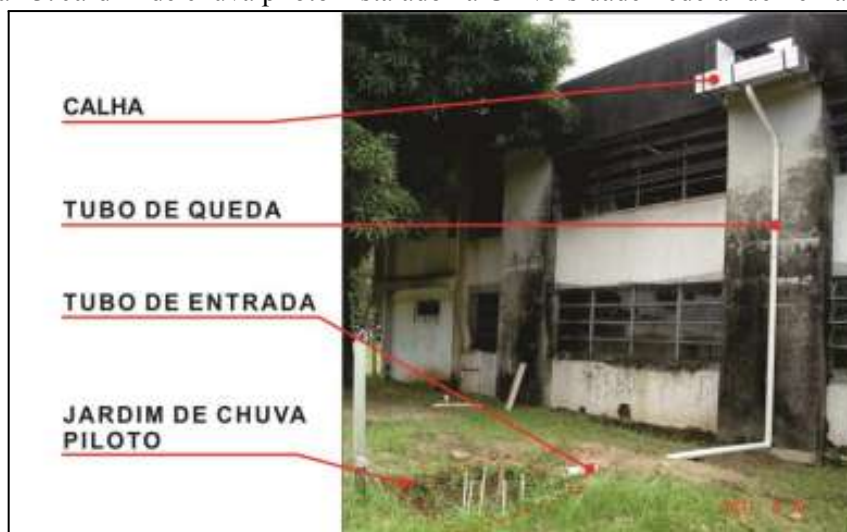
Figura 13: Jardim de chuva piloto instalado na Universidade Federal de Pernambuco.
