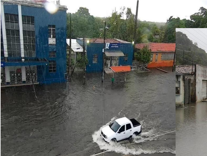
Figura 10: João Pessoa registrou pontos de alagamento em Mangabeira
