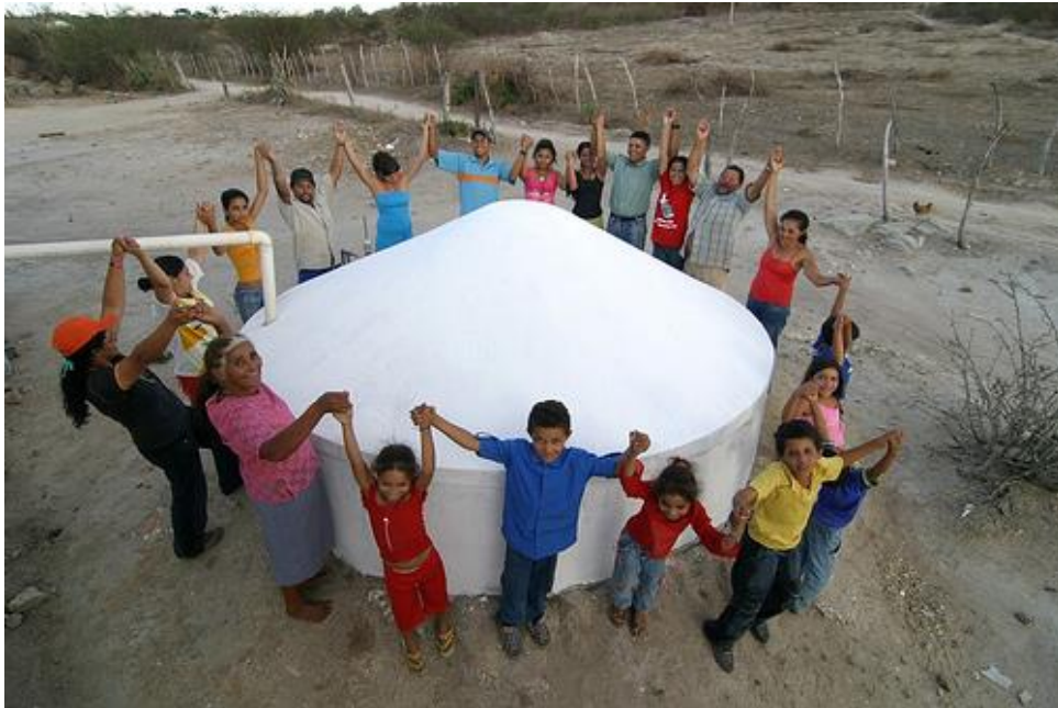
Figura 6a – Cisterna de placas de 16.000 litros de água
