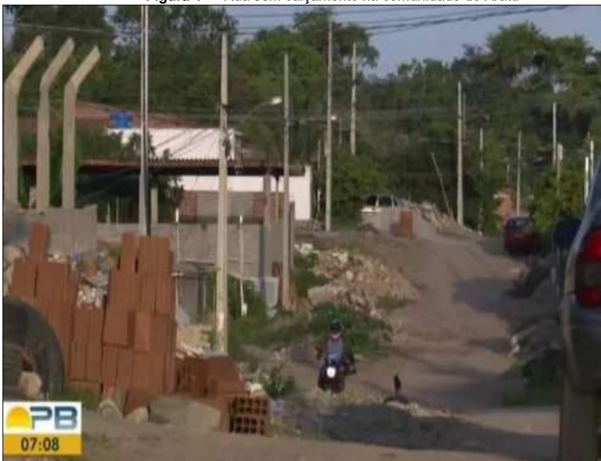
Figura 4 — Rua sem calçamento na comunidade do Aratu
