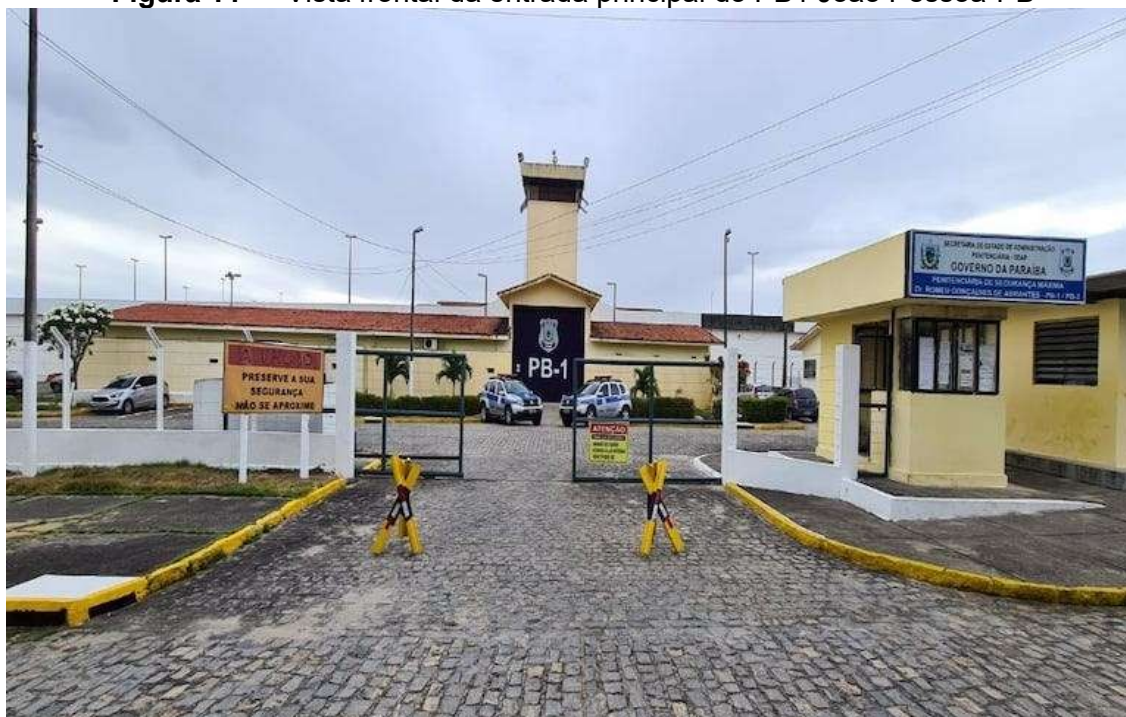
Figura 11 — Vista frontal da entrada principal do PB1 João Pessoa-PB
