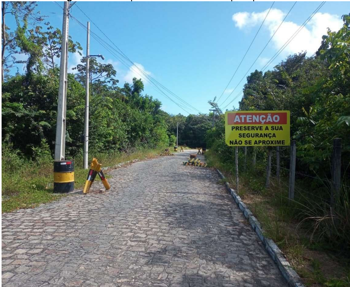
Figura 9 — Rua que dá acesso a entrada principal do PB1
