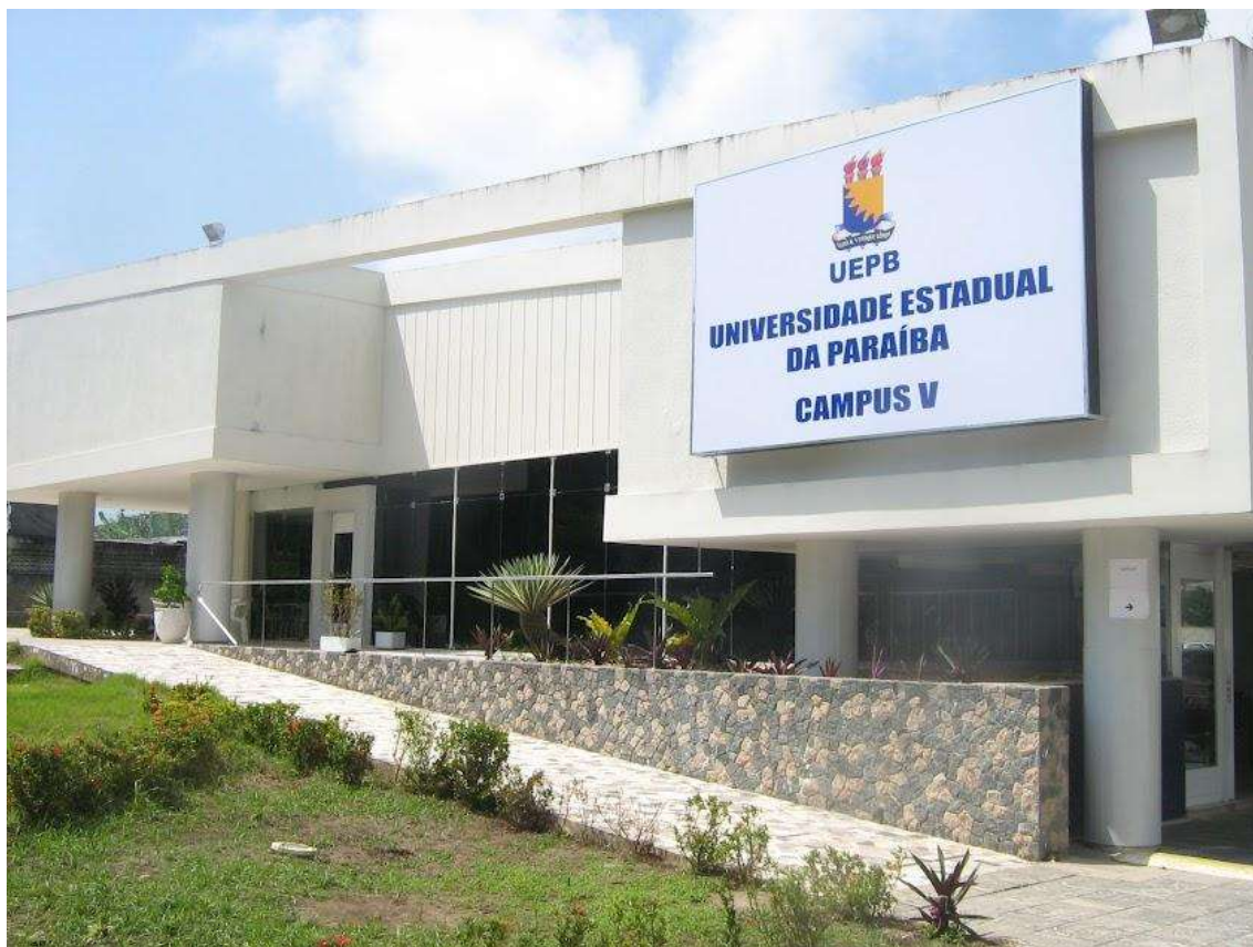
Figura 13 – Prédio alugado para o Campus V , na Av. Epitácio Pessoa, 1090 – João Pessoa-PB
