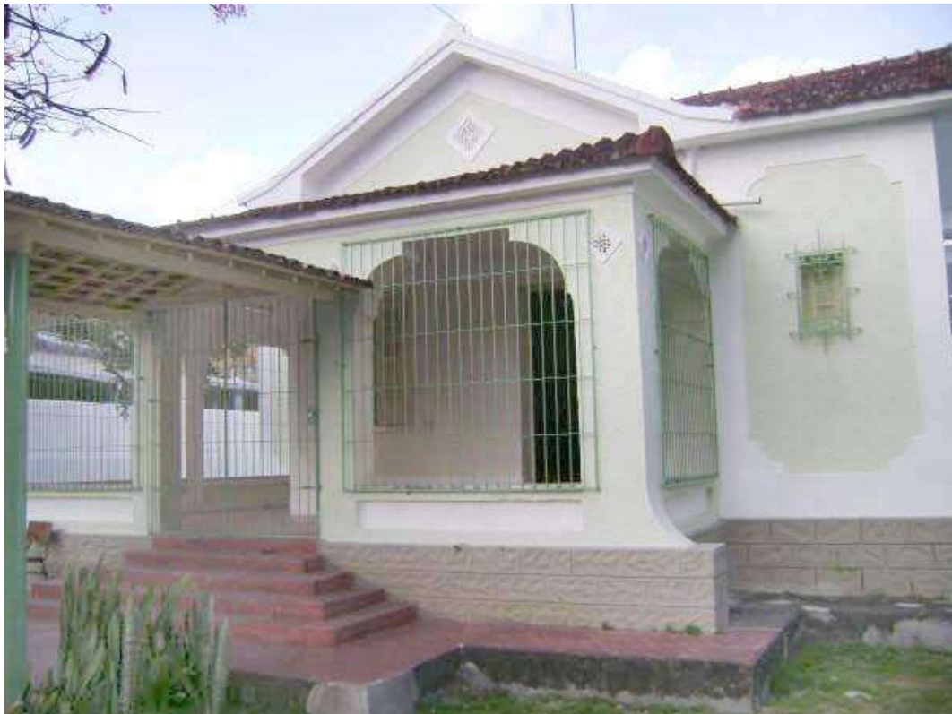
Figura 15 – Prédio do Campus V , na Rua Monsenhor Walfredo Leal - João Pessoa-PB
