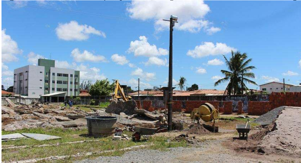
Figura 22 – Obra de ampliação do Colégio Estadual José Lins do Rego
