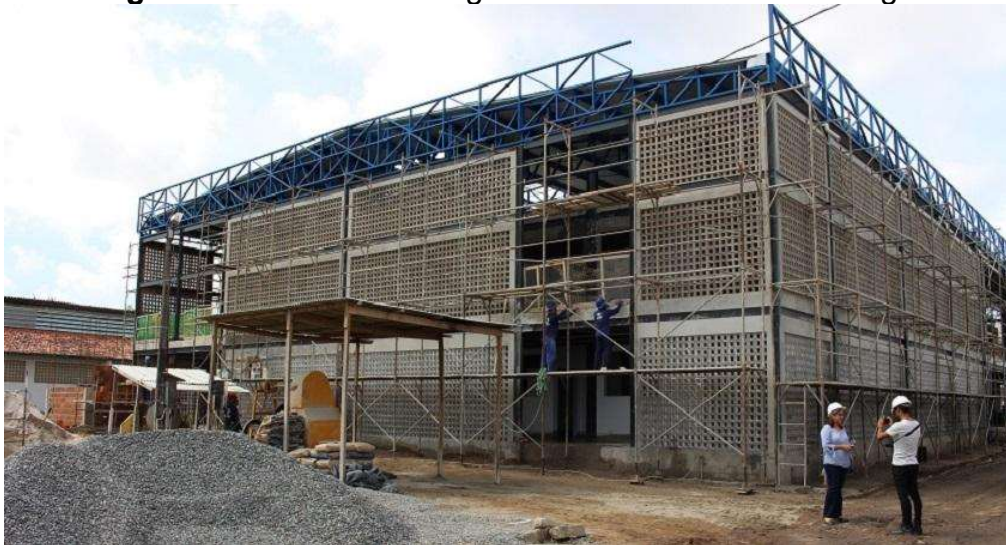
Figura 23 – Obra no Colégio Estadual José Lins do Rego
