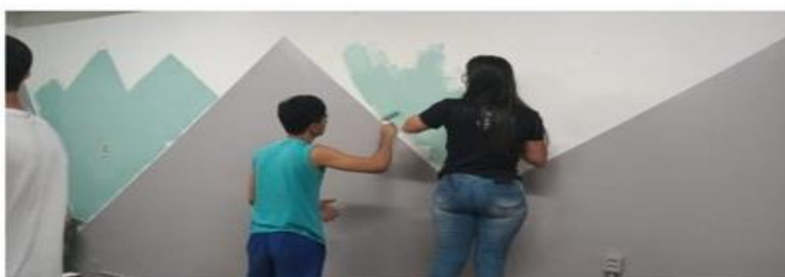
Imagem 3: Pintura realizada durante a reforma de 2019
