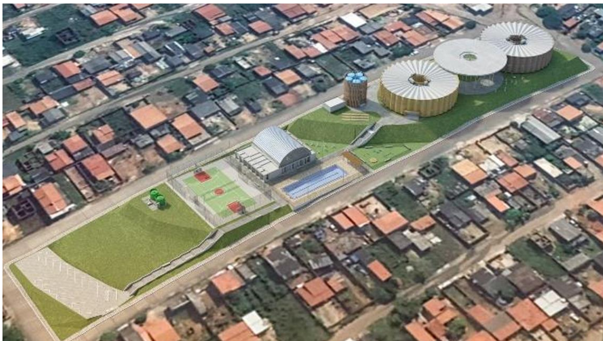
Figura 6 – Estrutura da Usina da Paz de Parauapebas
