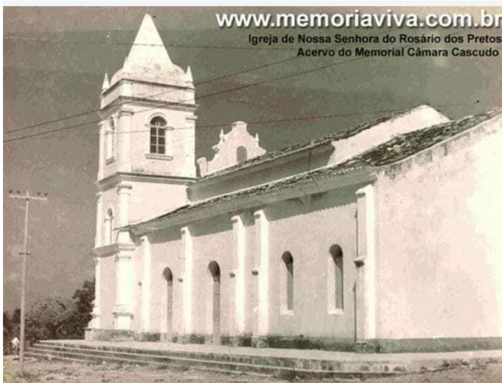
Figura 3: Visão lateral da Igreja do Rosário antes da Reforma:
