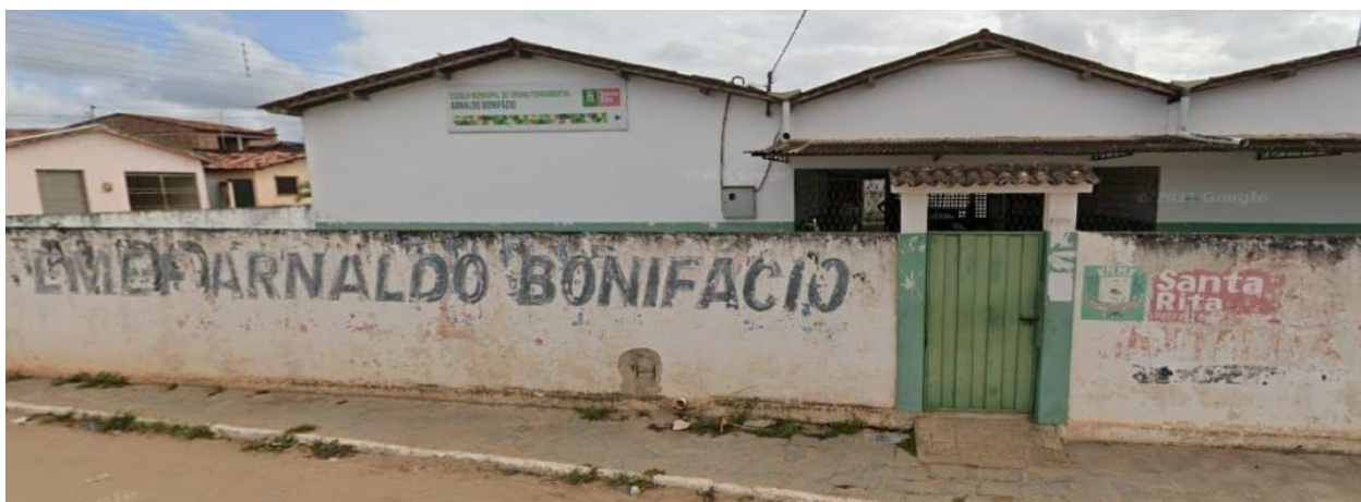
Figura 7- Fachada da escola
