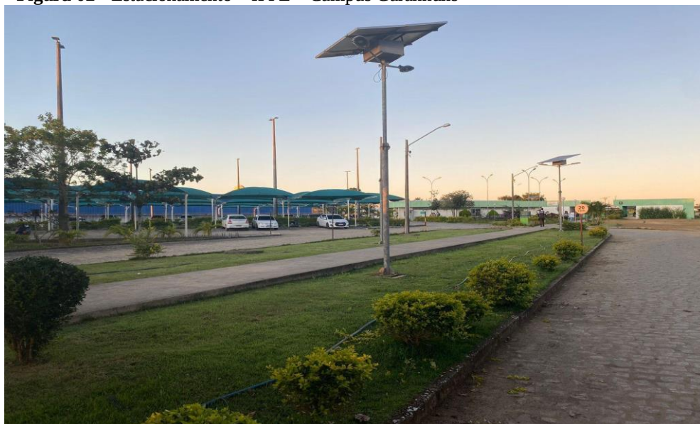
Figura 02 - Estacionamento – IFPE – Campus Garanhuns
