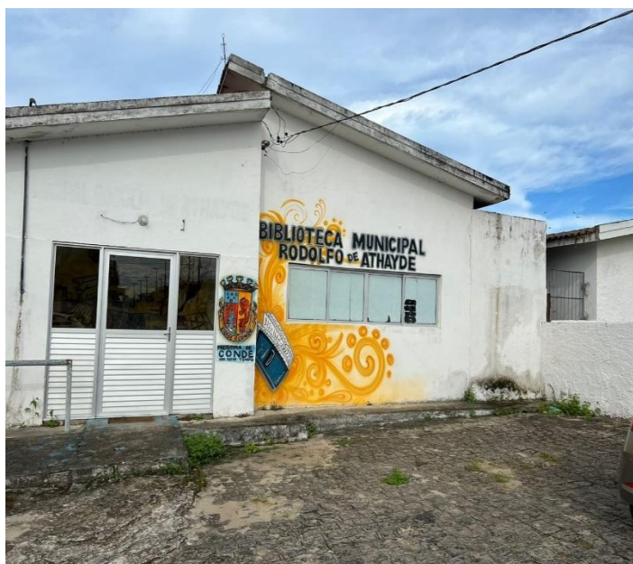
Figura 1 – Fachada da Biblioteca Pública Municipal de Conde
