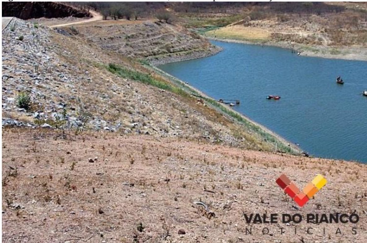
Figura 26 - Reservatório Serra Vermelha I, no município de Conceição-PB.
