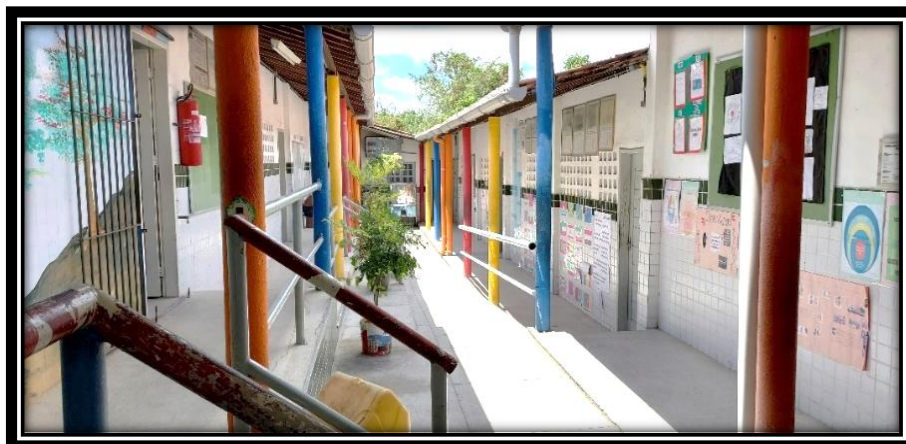
Figura 14 – ECI Irmã Joaquina Sampaio (Parte Interna)
