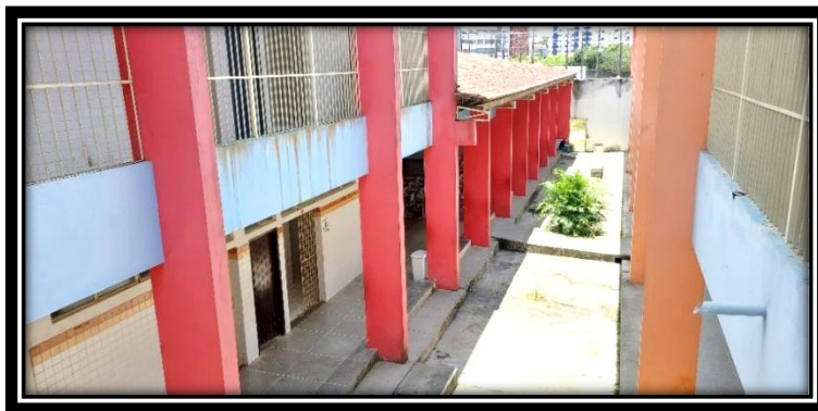
Figura 18 – ECI Monte Carmelo (Parte Interna)
