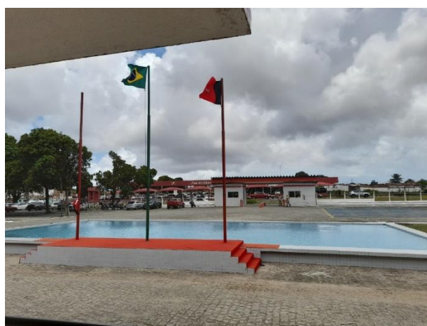
Figura 6 – Vista do Comando Geral
