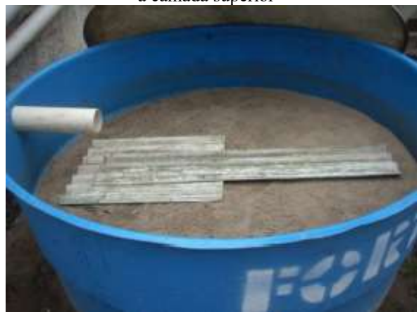
Figura 66: Colocação de telha de fibrocimento sobre a camada superior
