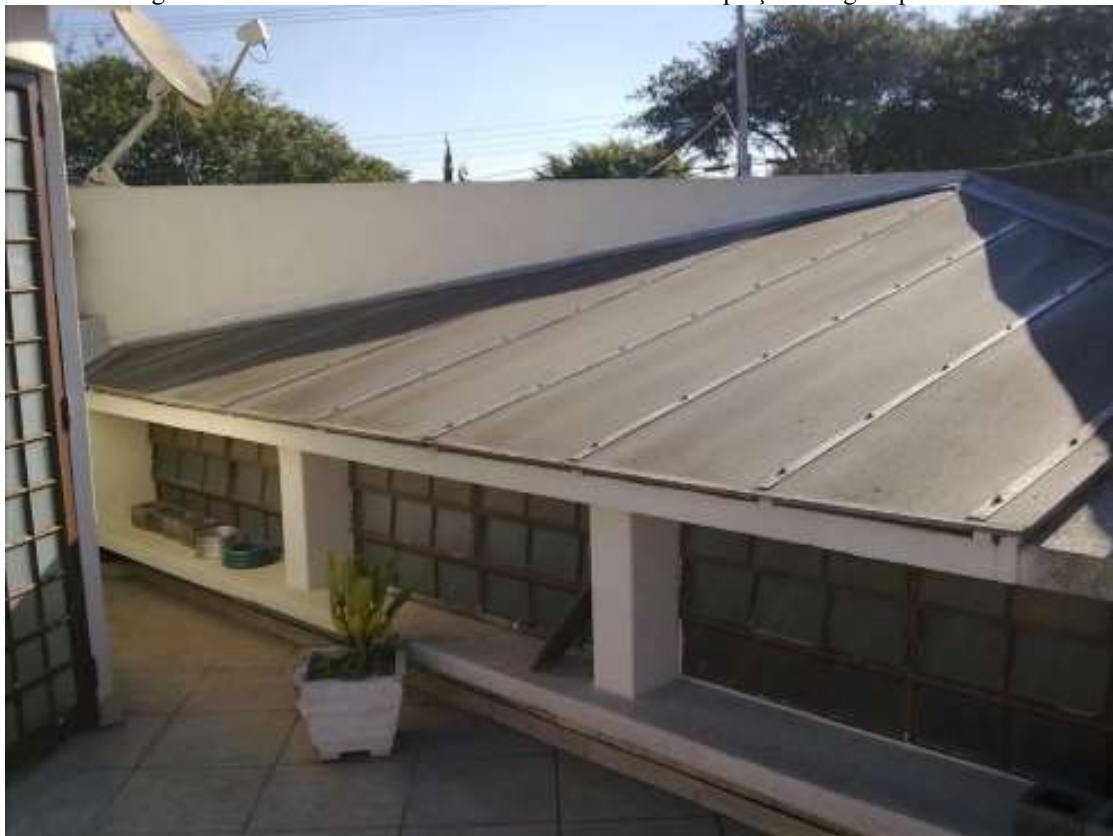
Figura 5: Vista frontal direita do telhado utilizado na captação de águas pluviais.
