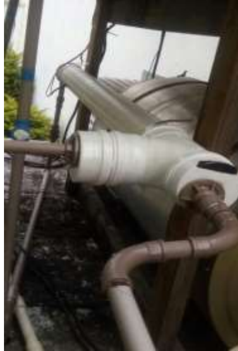
Figura 80: Sistema de desinfecção ultravioleta
