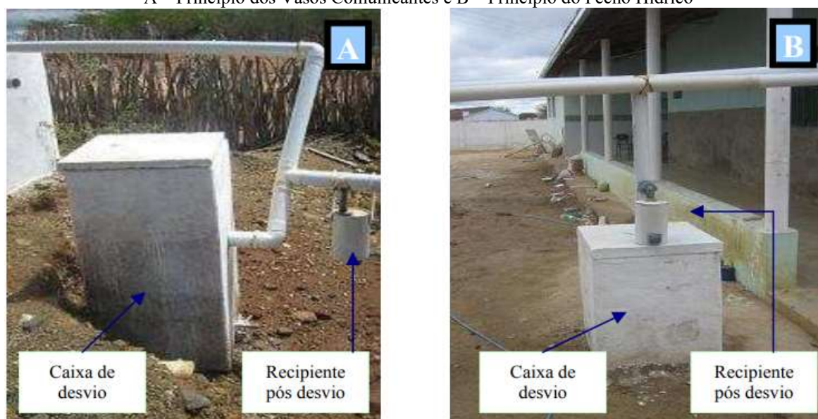
Figura 12: Sistema de desvios das primeiras águas empregado por Xavier et al. (2009) A – Princípio dos Vasos Comunicantes e B – Princípio do Fecho Hídrico
