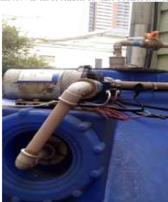
Figura 79: Válvula de controle da vazão e bomba fotovoltaica
