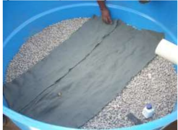
Figura 64: Colocação da manta geotêxtil entre camadas
