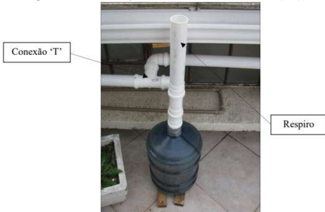
Figura 4: Sistema exclusão dos primeiros milímetros da chuva de Hirt e Santos (2011).
