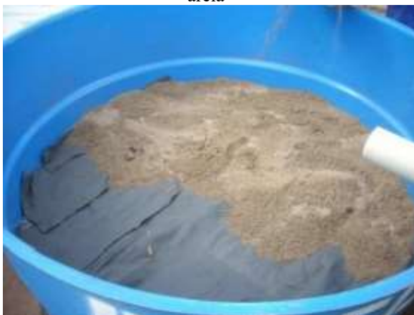
Figura 65: Preenchimento da camada superior com areia
