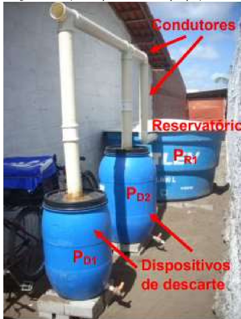
Figura 16: Ilustração do disposto de descarte da precipitação inicial
