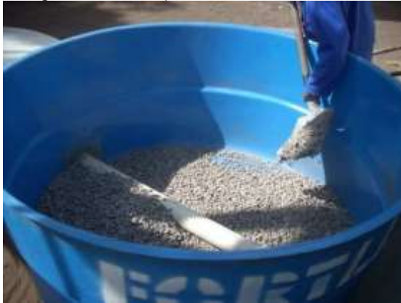
Figura 63: Colocação da brita na base do filtro
