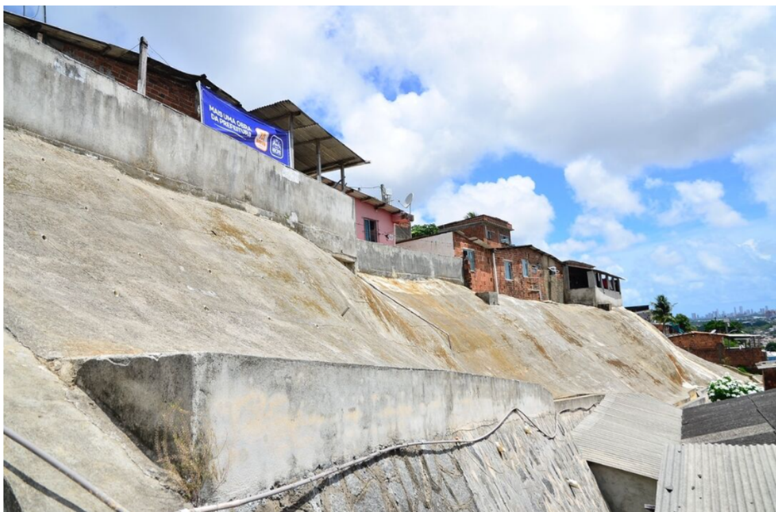
Figura 7: Revestimento em tela argamassada. Fonte: Arthur Mota (Folha de Pernambuco).
