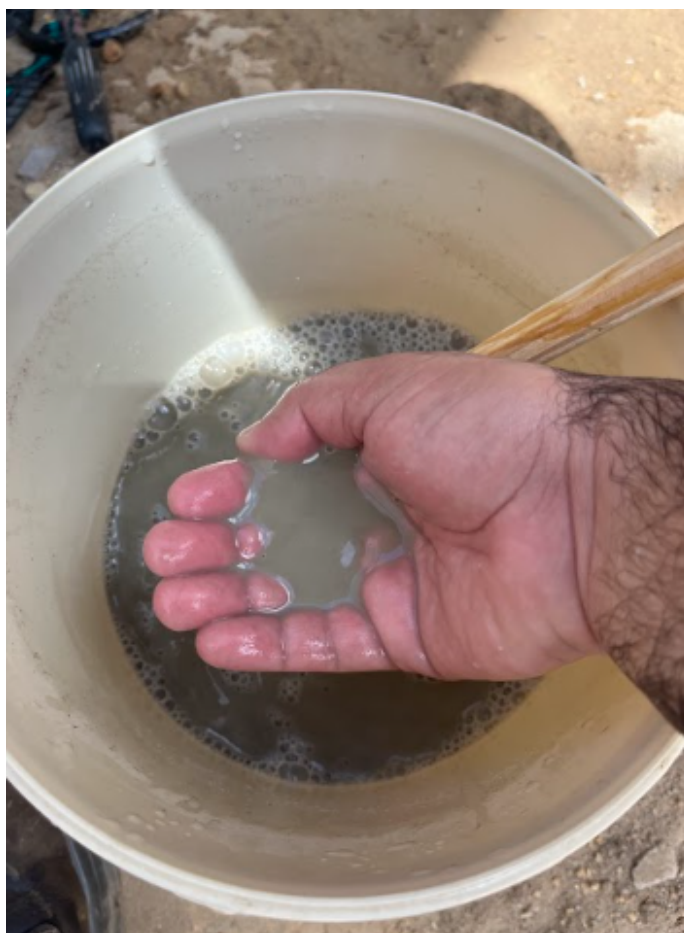
Figura 16: Mistura cimento e água para aplicação com pulverizador. Fonte: Autor.
