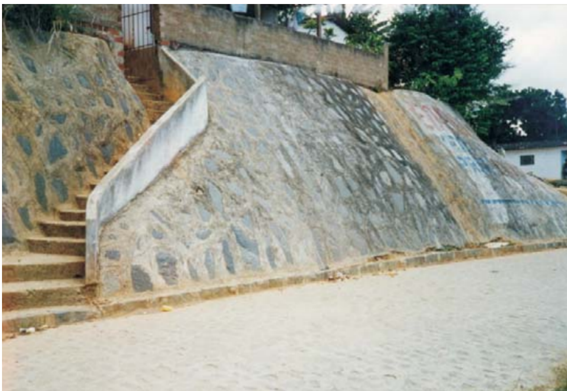
Figura 8: Revestimento com pano de pedras. Fonte: FIDEM-PE (2003).
