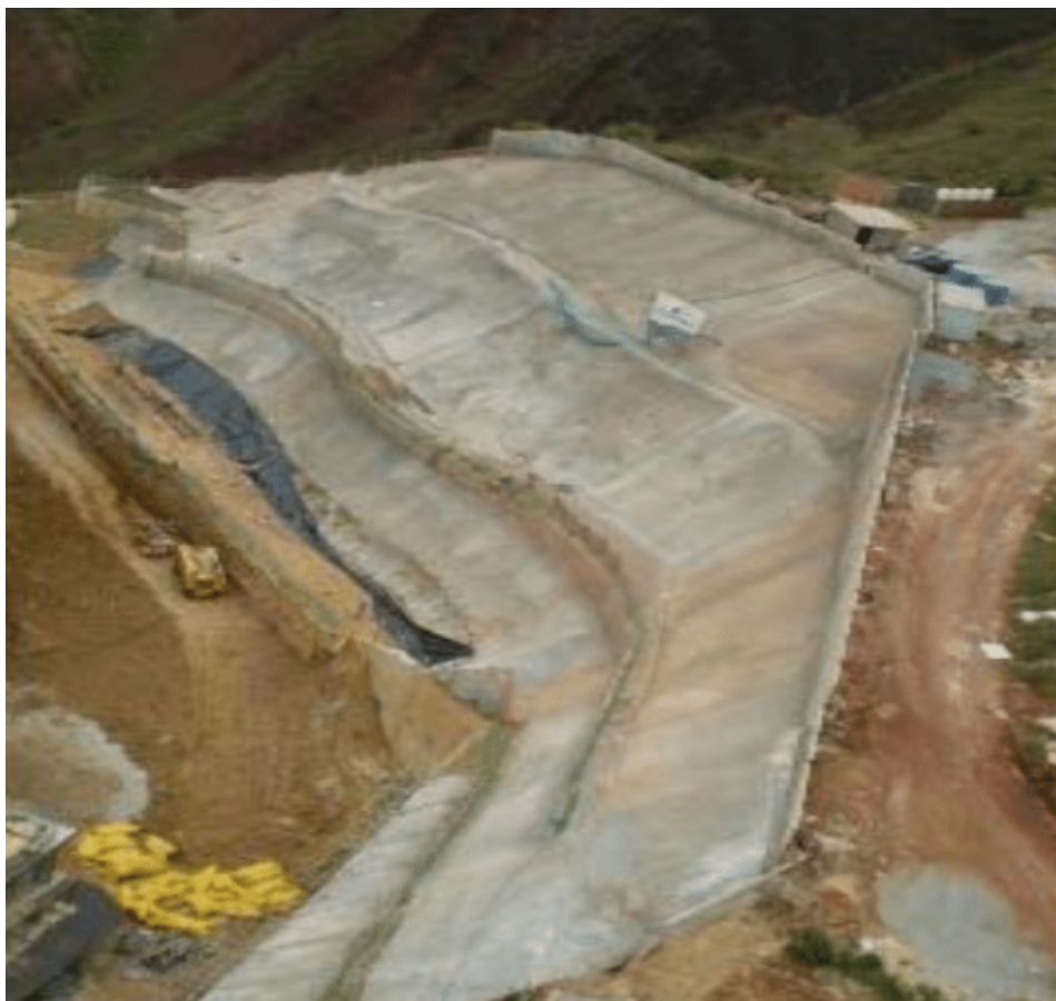
Figura 6: Revestimento cimentado em talude. Fonte: INTEC.
