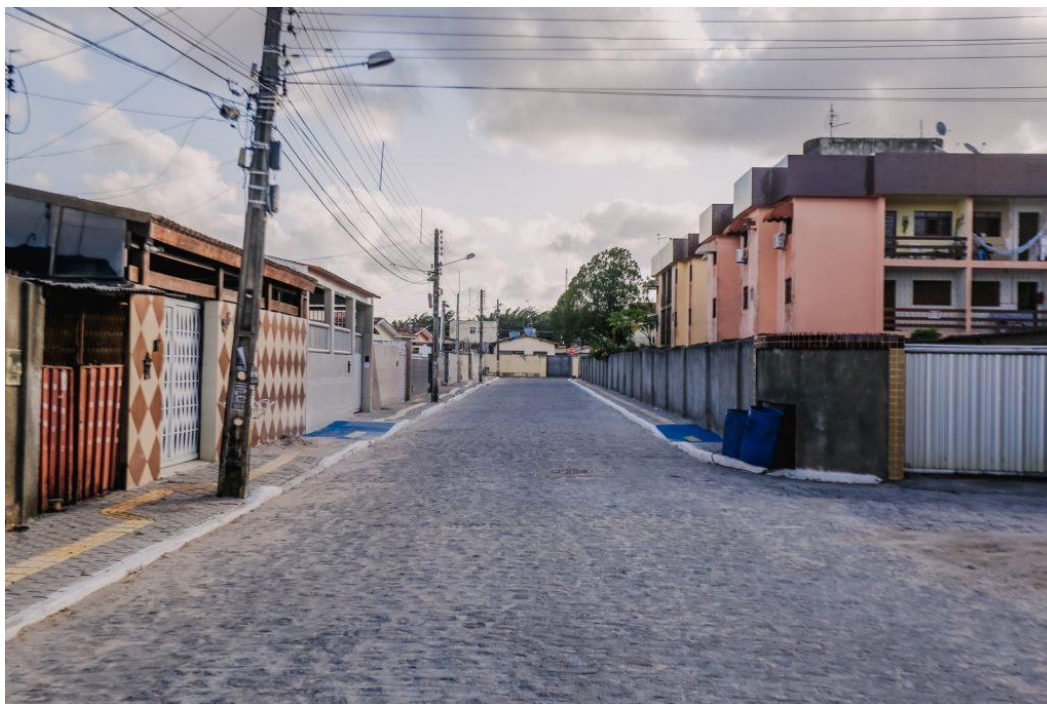
Figura 4: Obra de execução de pavimentação e passeio.
