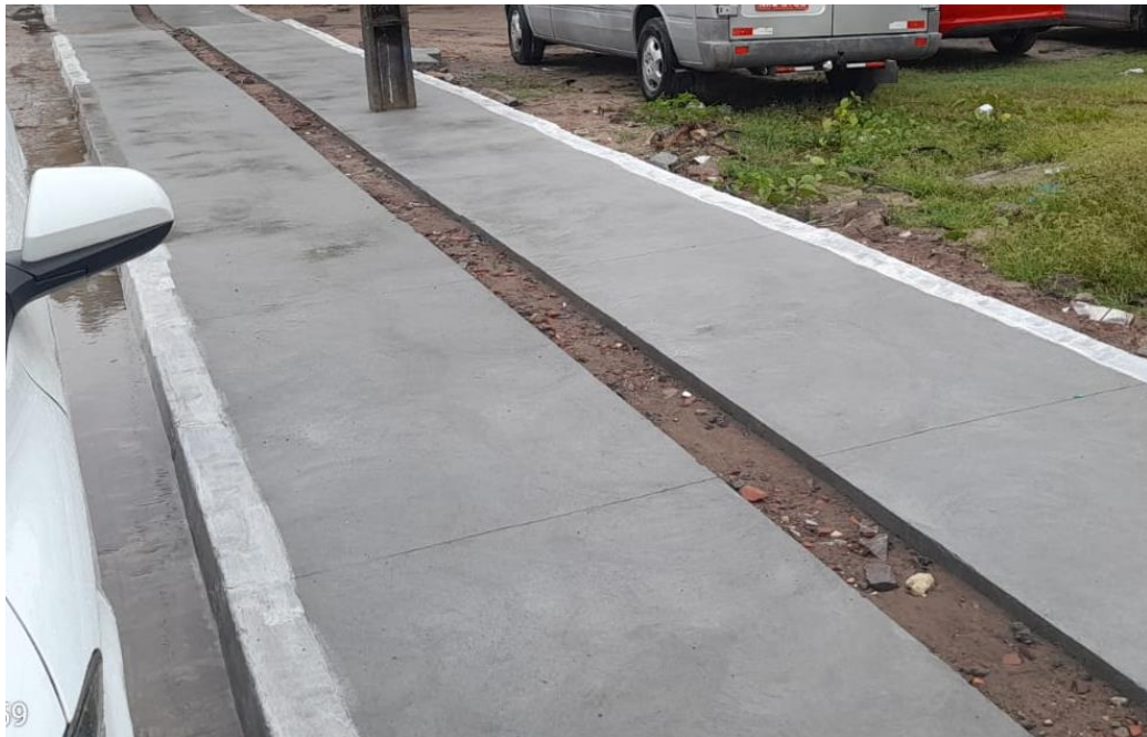
Figura 5: Execução de passeio com abertura para assentamento de piso tátil.
