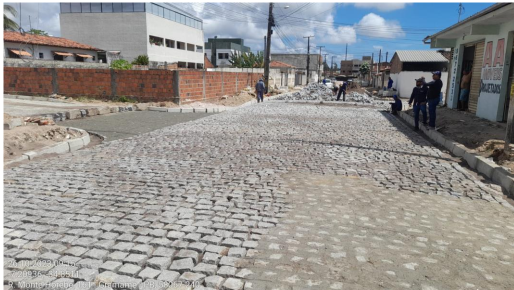
Figura 7: Execução de pavimentação em paralelepípedo.
