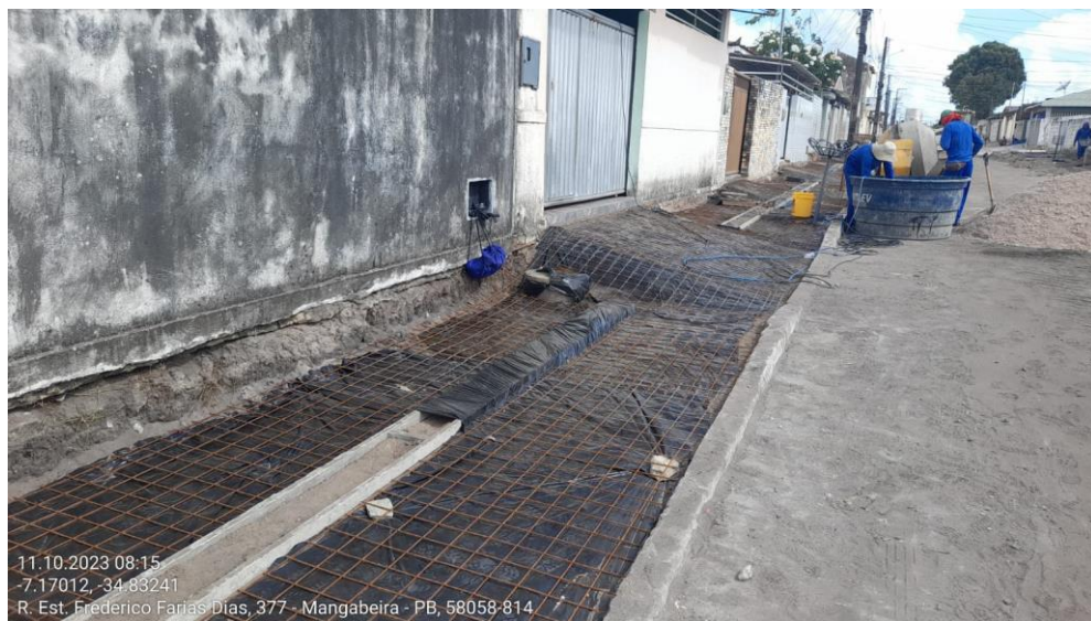
Figura 6: Preparação de calçamento para concretagem.
