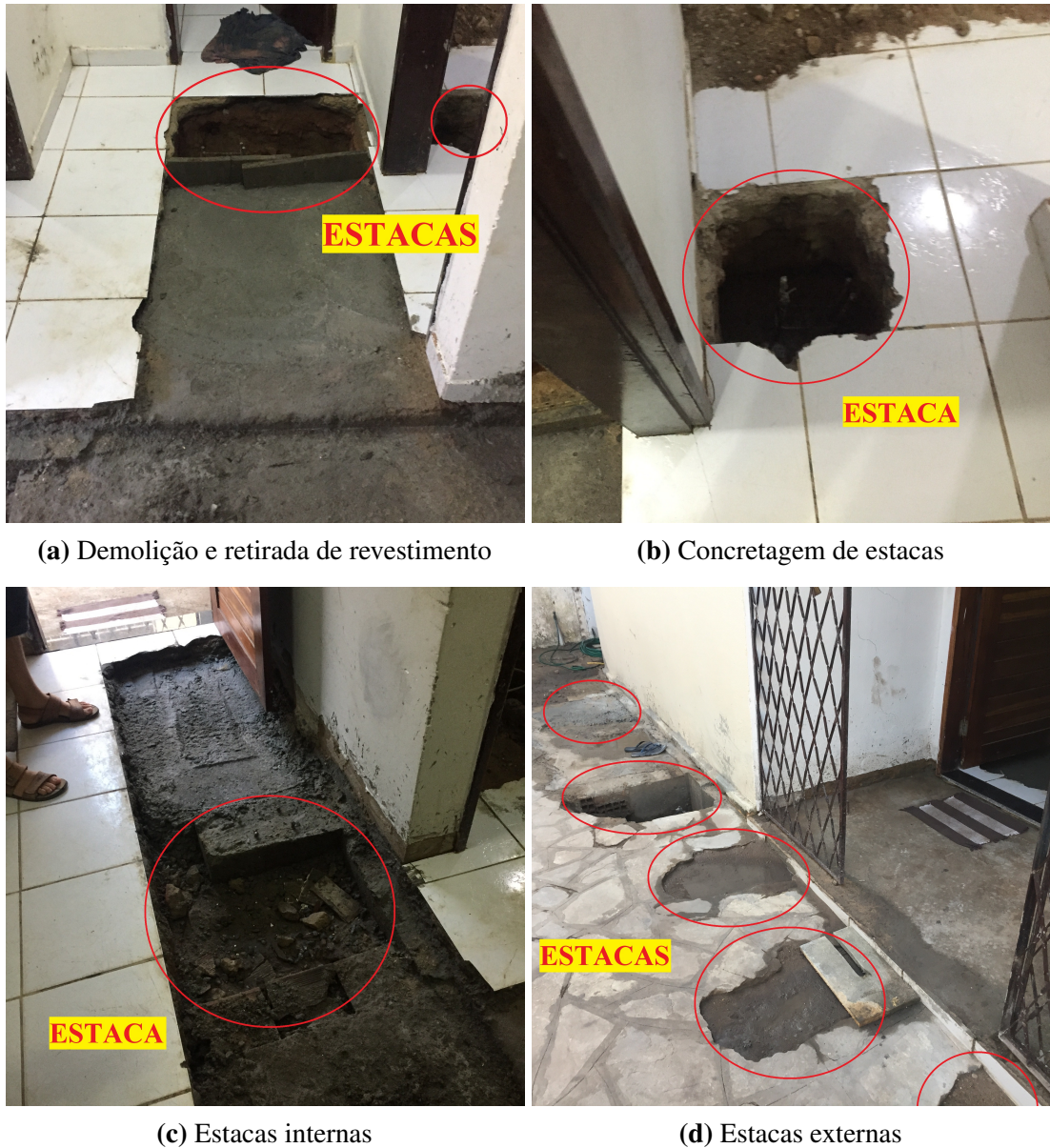
Figura 26 – Execução da solução escolhida
