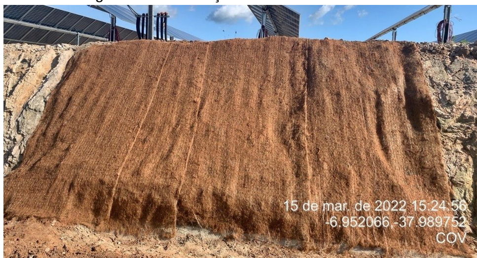
Figura 07 – Instalação de biomanta em talude
