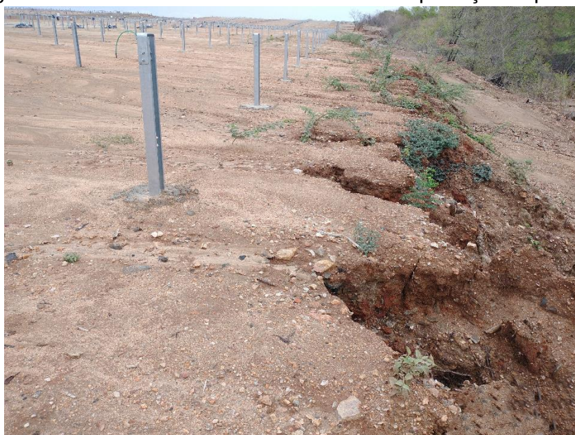
Figura 02 – Erosões em crista de talude sem proteção superficial
