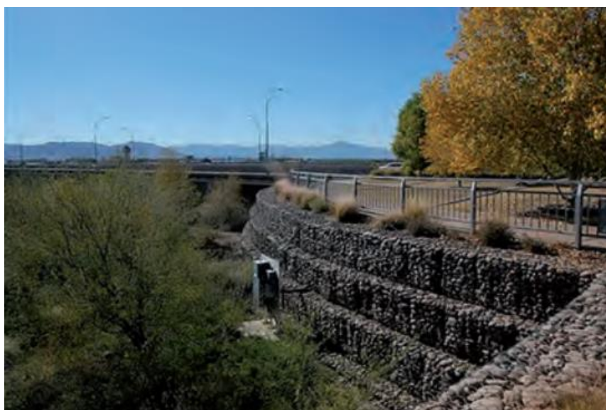
Figura 5 - Muro de gabiões
