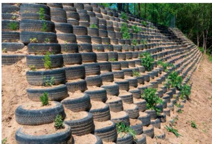
Figura 7 - Muro de solo-pneus
