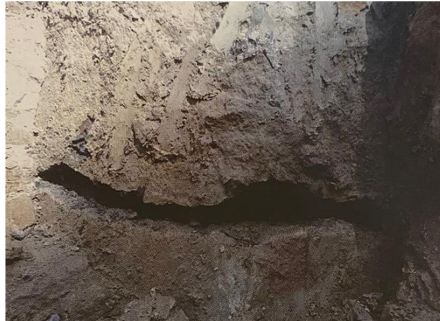
Figura 17 - Estaca com descontinuidade
