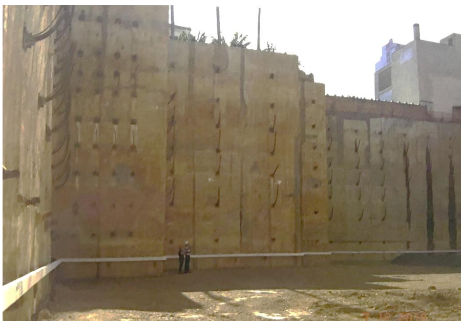
Figura 10 - Parede diafragma atirantada após escavação.
