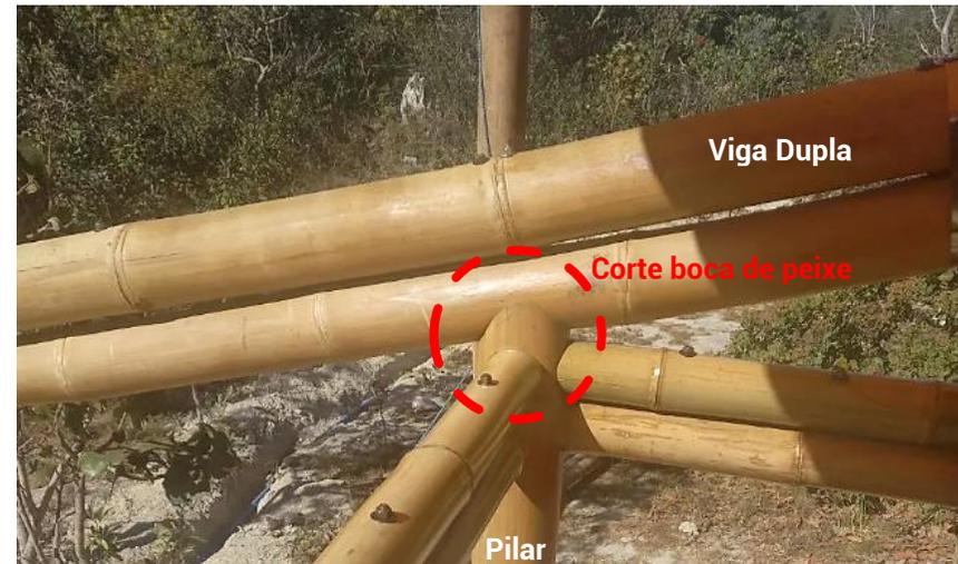
**Figura 114** - Viga dupla inclinada apoiada no pilar.
