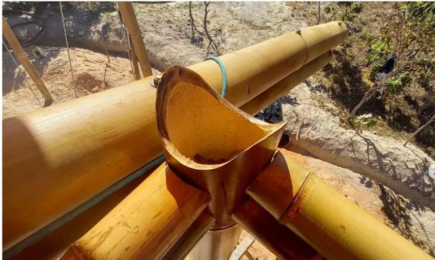
**Figura 113** - Corte Boca de Peixe no topo do pilar.
