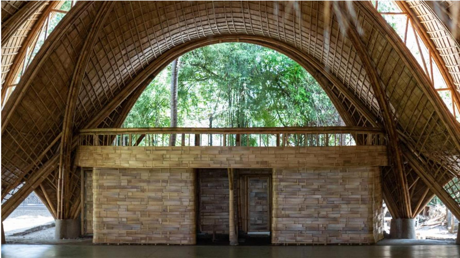
**Figura 93** - Volume interno em trama de bambu.
