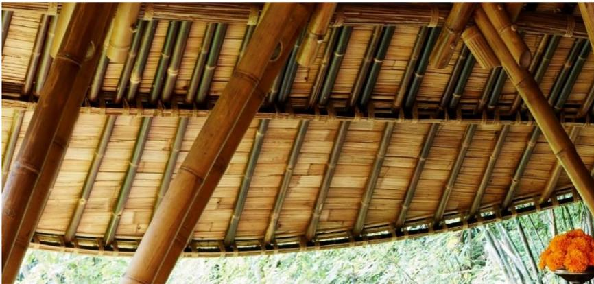
**Figura 64** - Forro em esterilha de bambu.
