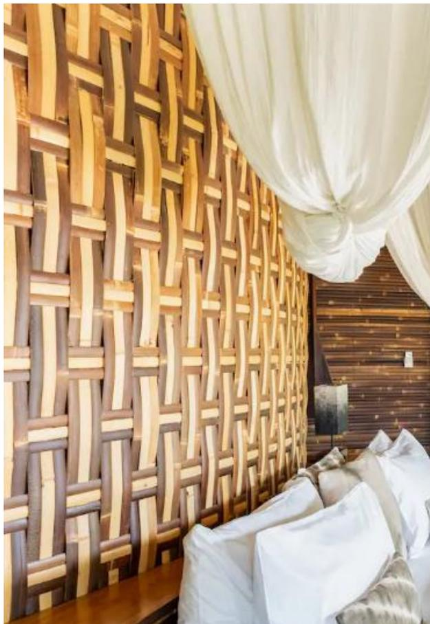
**Figura 61** - Painel de tramas em ripas de bambu.
