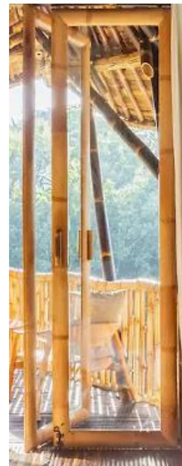
**Figura 59** - Esquadria em caixilho de bambu e lâmina de vidro.
