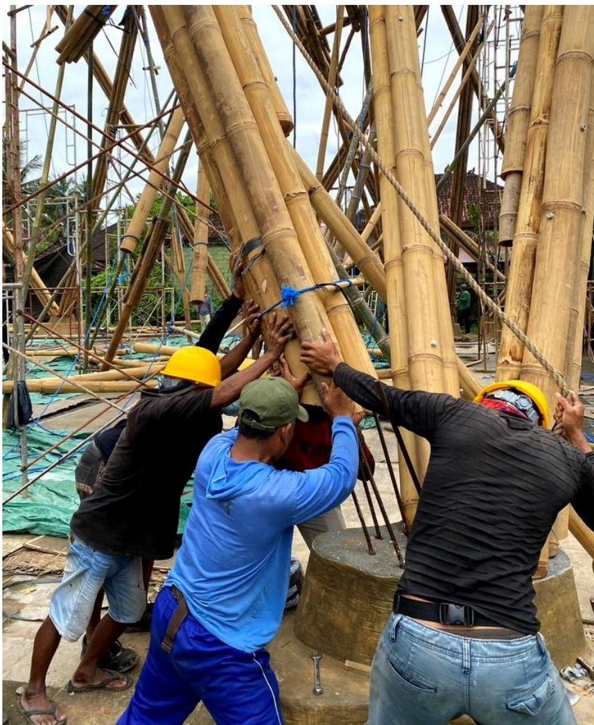
**Figura 71** - Execução da conexão entre os arcos e a base.
