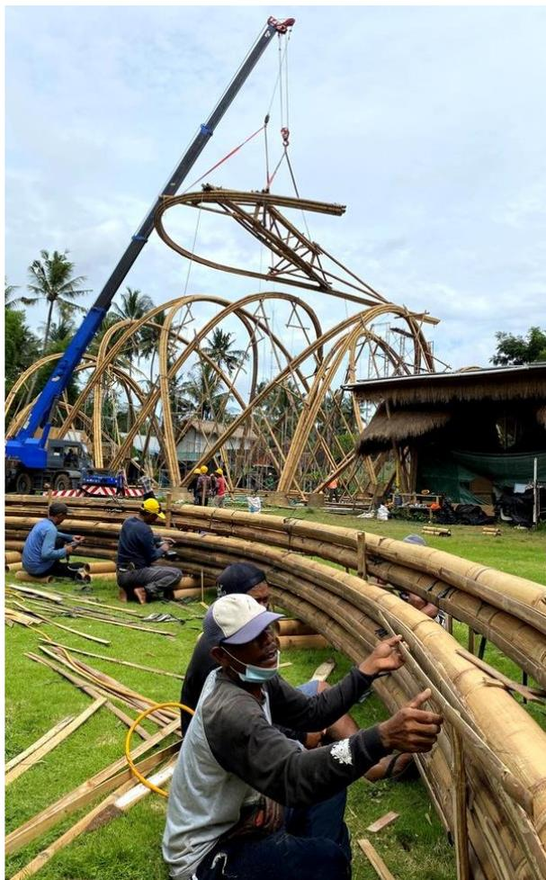
**Figura 76** - Processo construtivo da conexão de travamento do arco.
