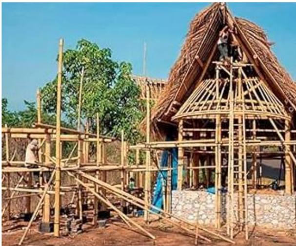
Figura 29 - Registro do processo construtivo da casa balinesa tradicional.
