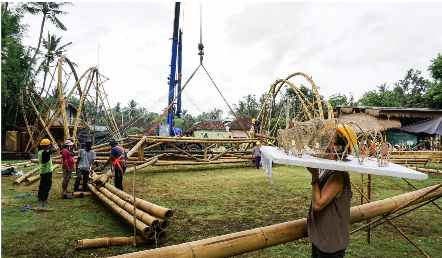
**Figura 80** - O uso da maquete como instrumento de auxílio no canteiro de obra.
