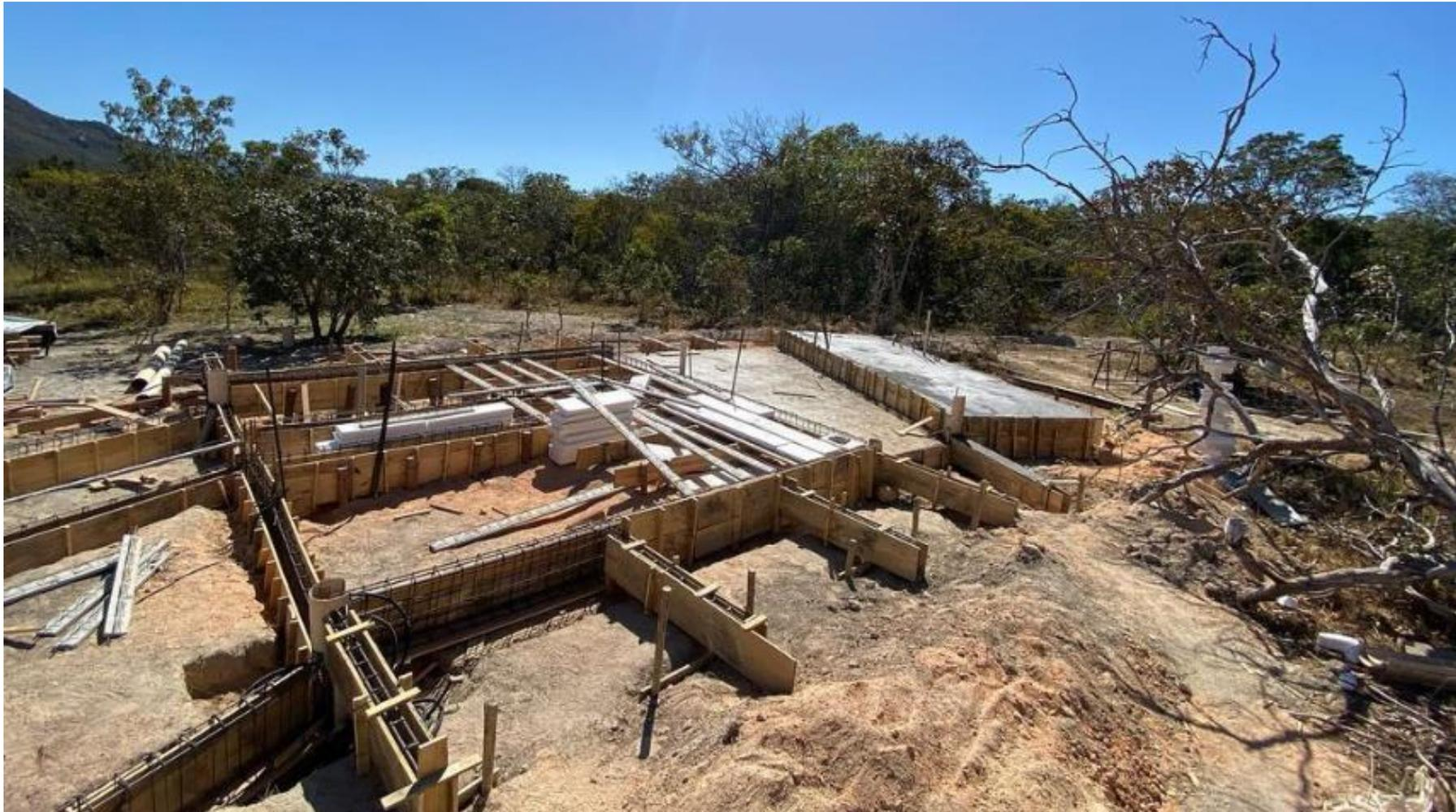
**Figura 105** - Processo construtivo do radier de embasamento.
