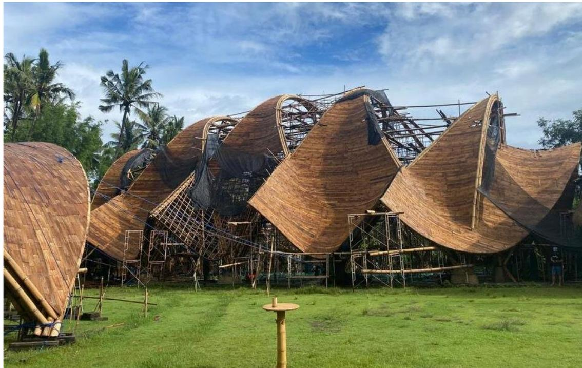
**Figura 95** - Forro em esterilhas de bambu na cobertura das *gridshells*.
