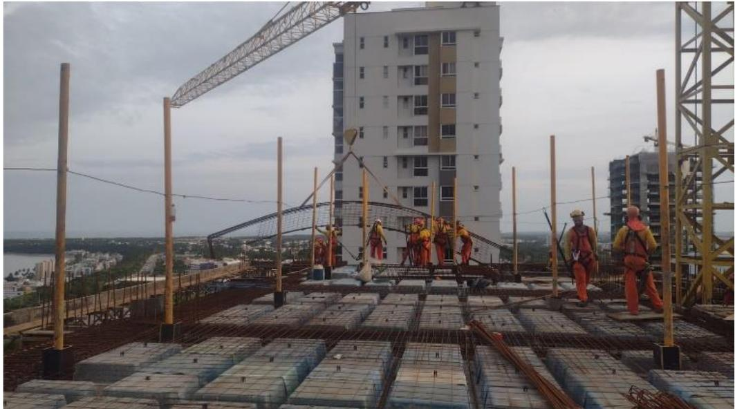
*Figura 30 - Armação das Lajes - Fonte: Autoria Própria*
