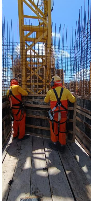
*Figura 26 - Desforma das Vigas e Lajes - Fonte: Autoria Própria*
