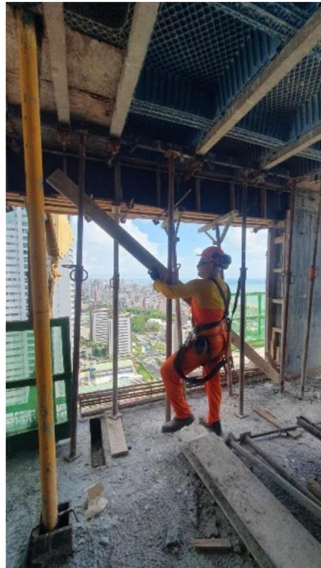
*Figura 27 - Separar Armação das Lajes - Fonte: Autoria Própria*
