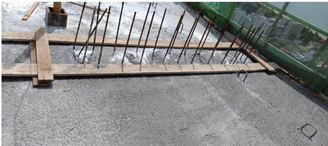
**Figura 23 - Armação das Vigas - Fonte: Autoria Própria**
