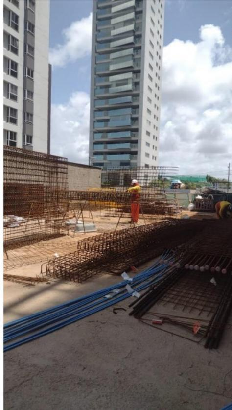
**Figura 24 - Montagem dos Pilares – Fonte: Autoria Própria**
