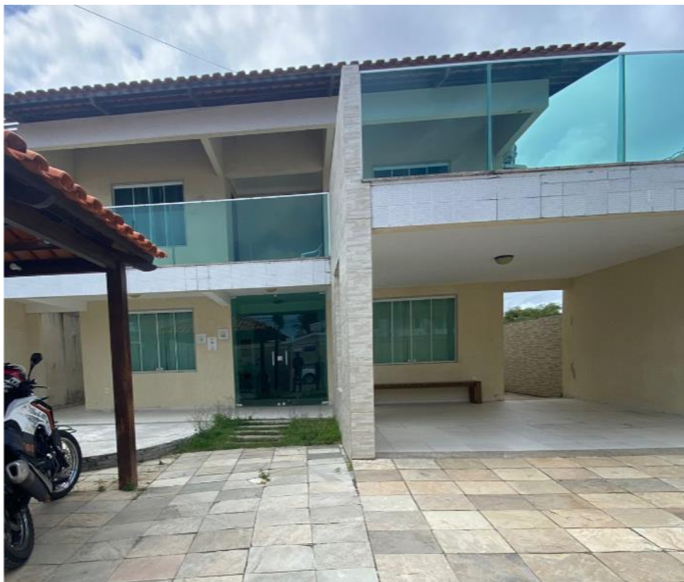
Figura 15 – Propriedade a ser demolida
