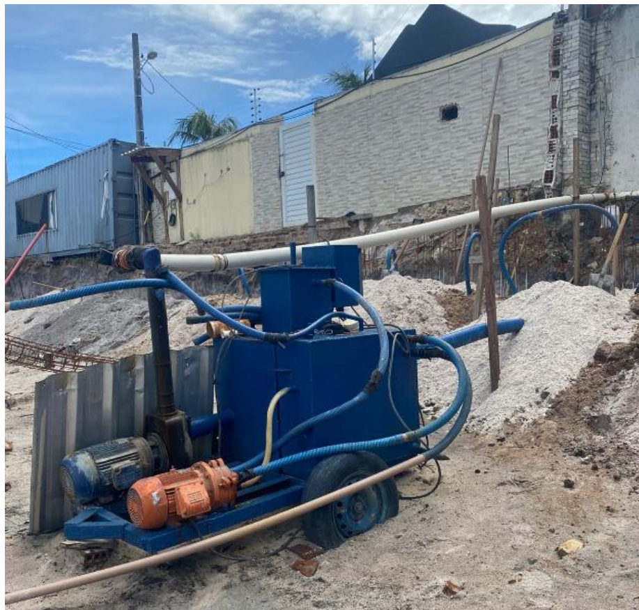
Figura 12 – Estação de rebaixamento do lençol freático
