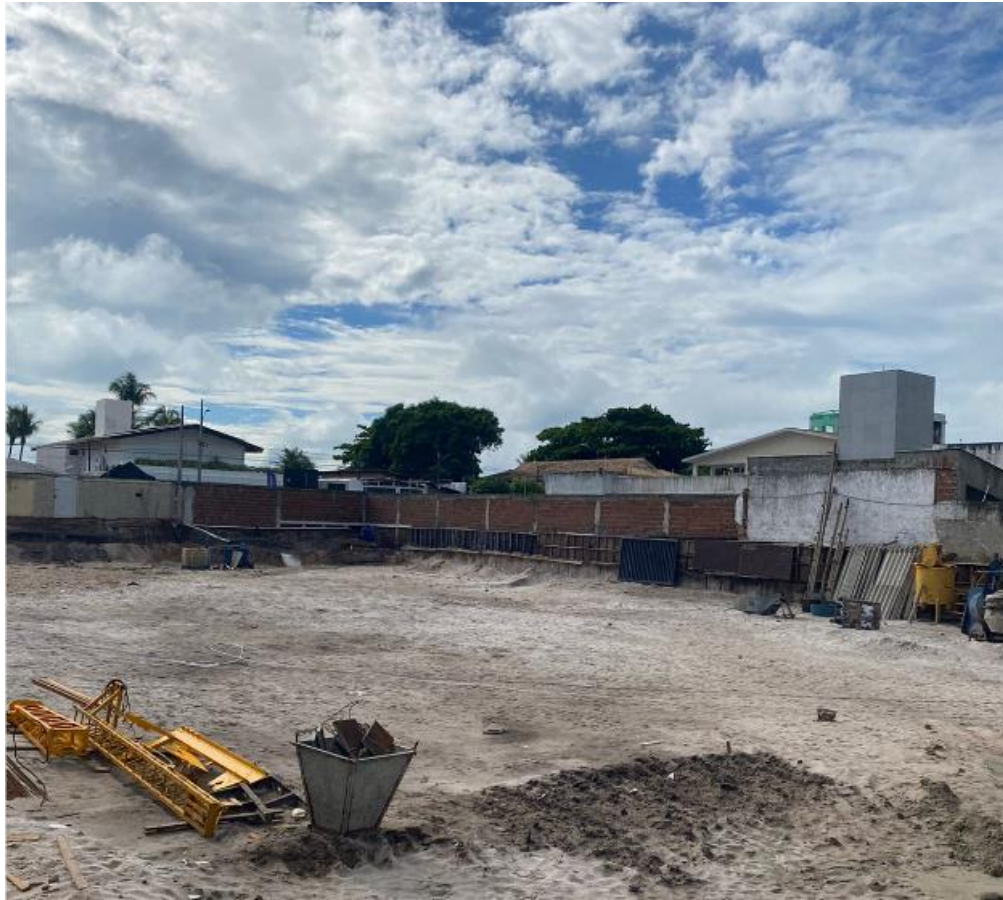
Figura 16 – Fase final da etapa de contenção
