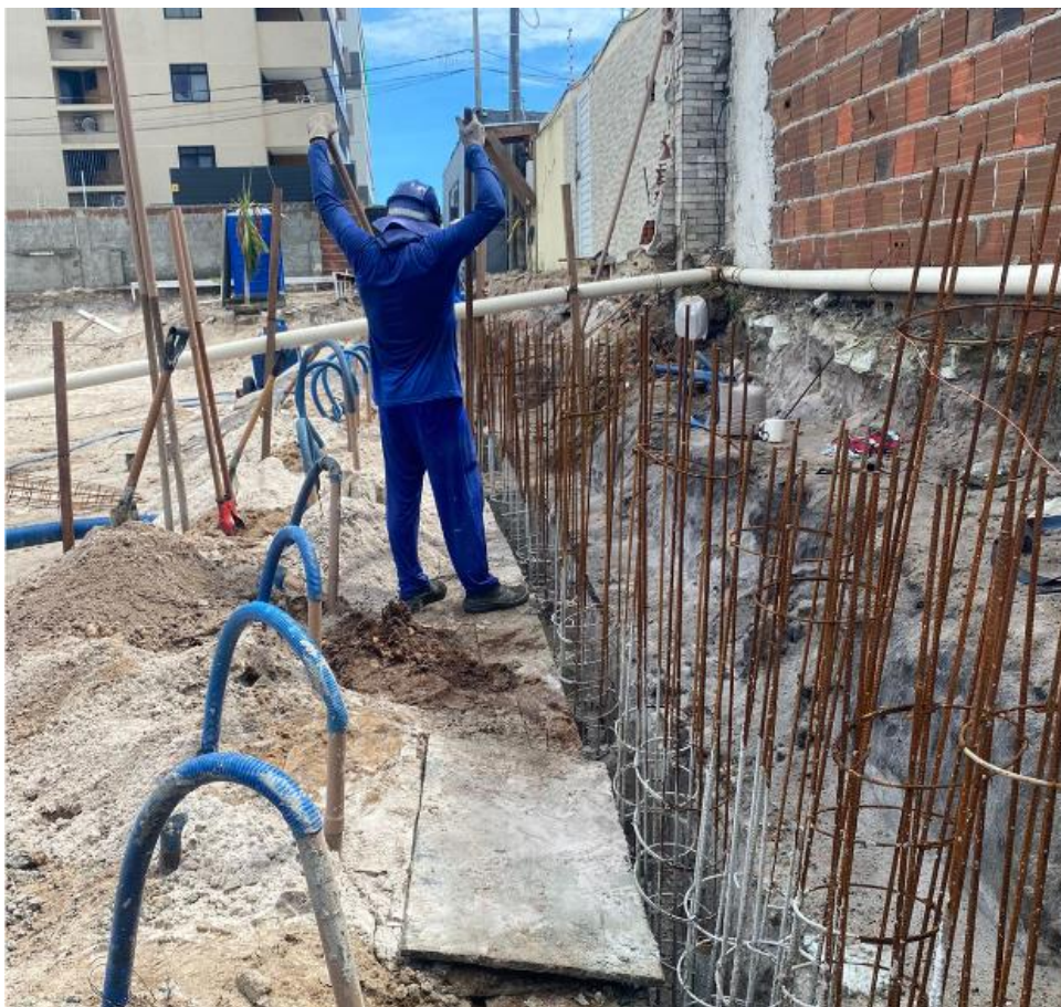
Figura 11 – Execução da escavação manual das estacas de contenção
