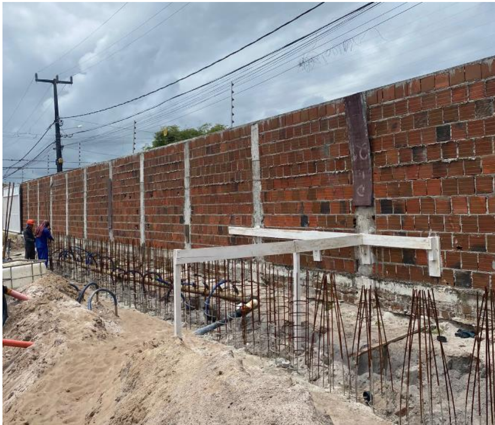
Figura 13 – Concretagem das primeiras estacas
