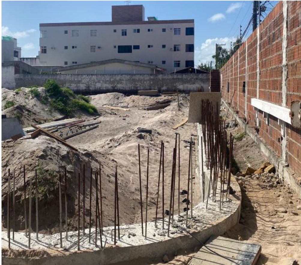
Figura 14 – Estacas após a concretagem
