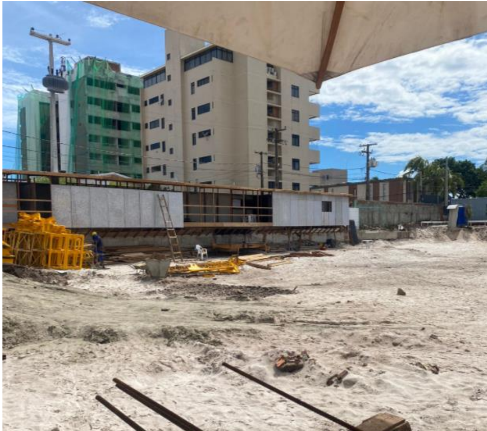
Figura 17 – Construção do canteiro
