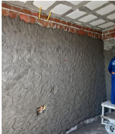
Figura 02 - Execução de emboço em alvenaria
