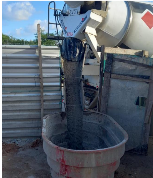
Figura 04 - Descarga de argamassa estabilizada em obra
