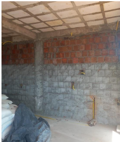
Figura 01 - Execução de chapisco em alvenaria
