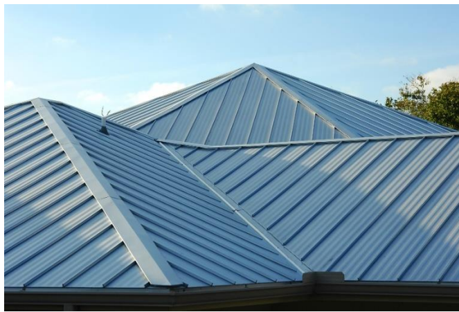
Figura 12 - Representação de painel metálico
