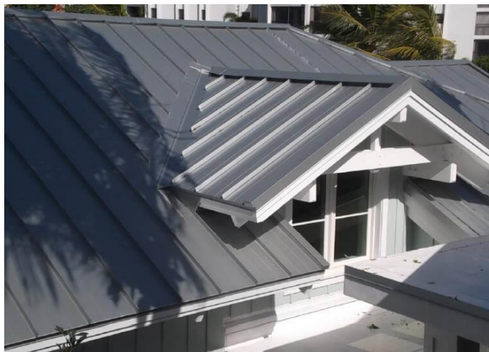
Figura 13 - Representação de painel metálico
