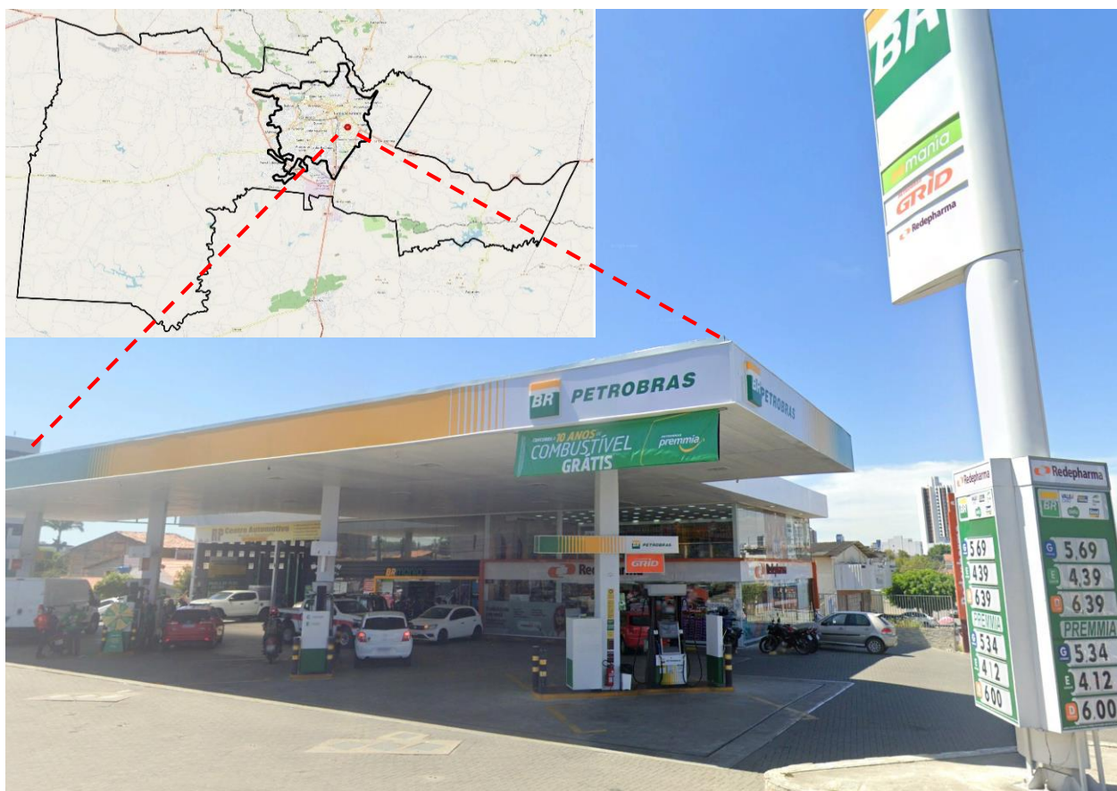
Figura 32. Posto de combustível em Campina Grande.
