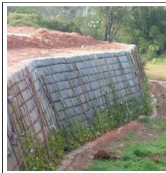
Figura 11 – Muro de contenção de solo reforçado com face envelopada, revestida com vegetação
