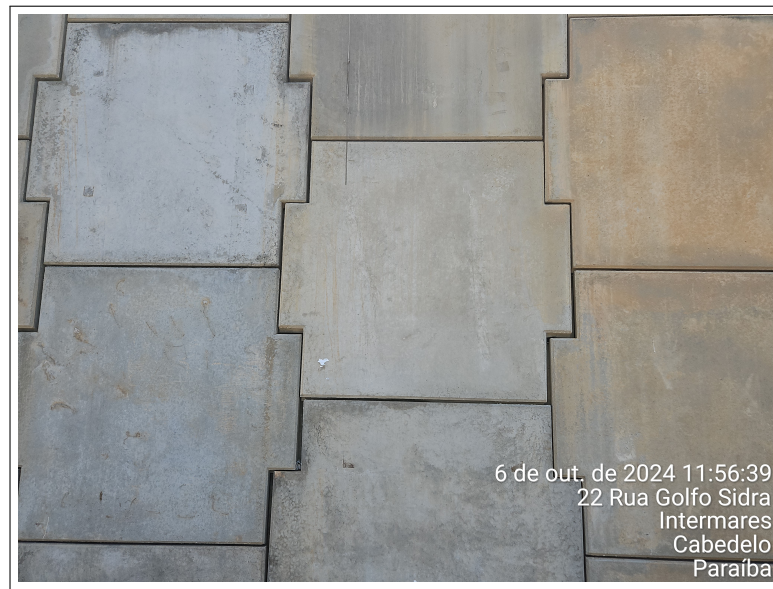
Figura 50 – Placas desaprumadas
