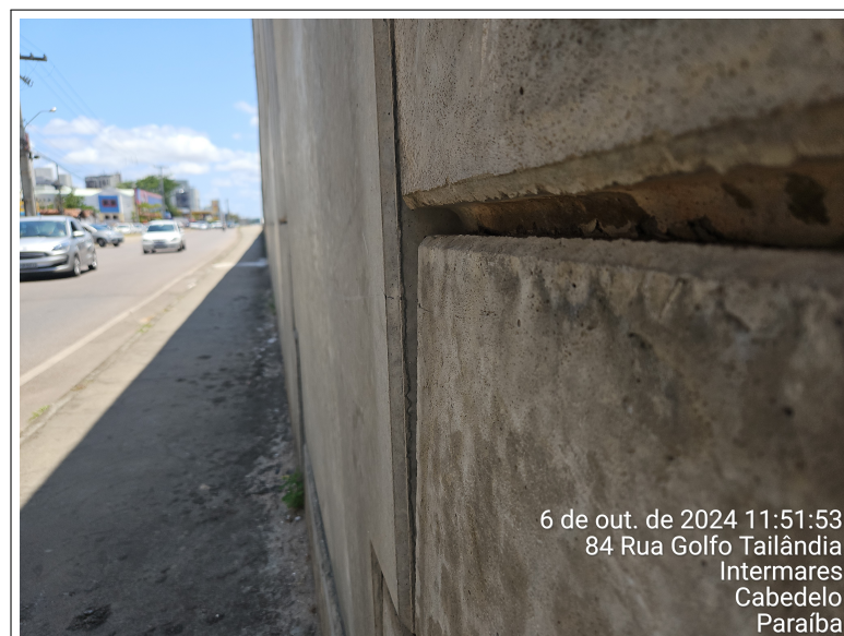
Figura 51 – Placas desniveladas
