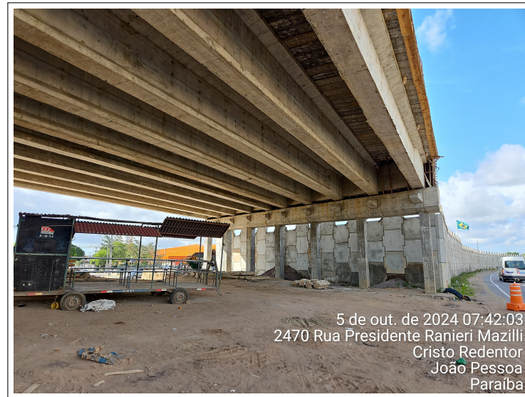
Figura 20 – Viaduto 2 - Água Fria
