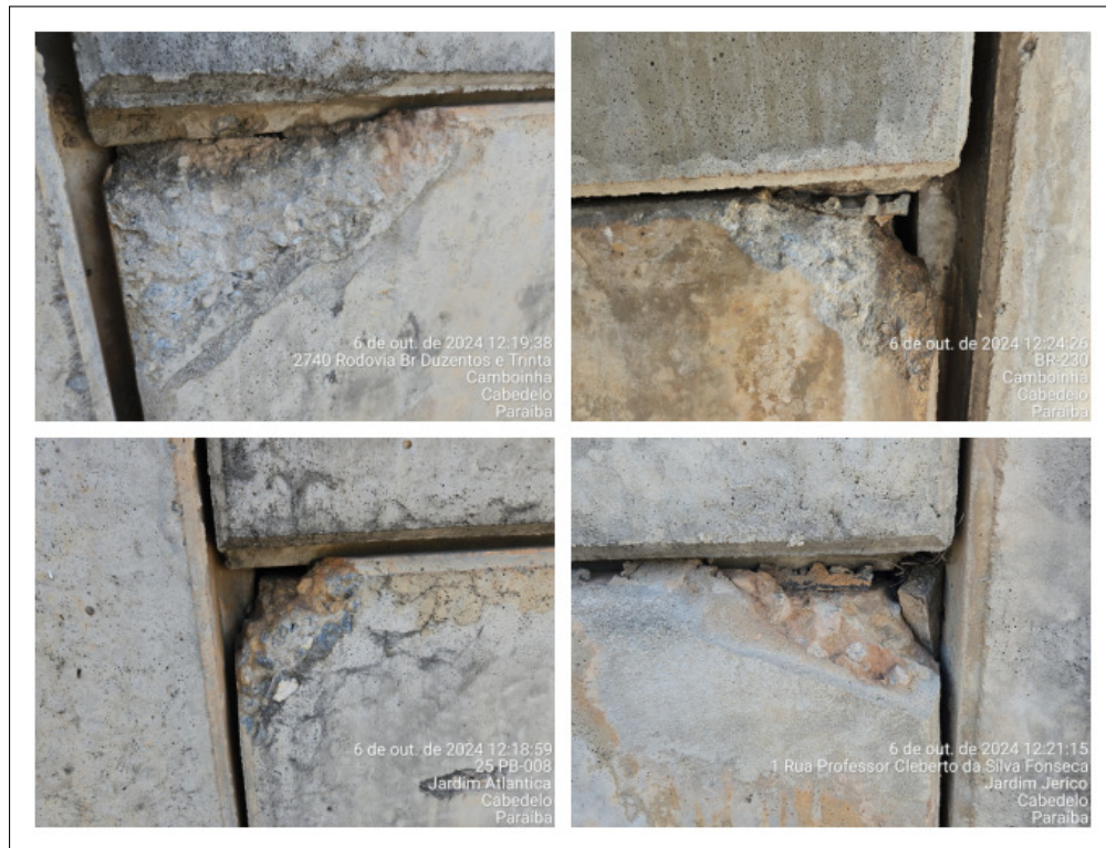
Figura 55 – Painéis danificados
