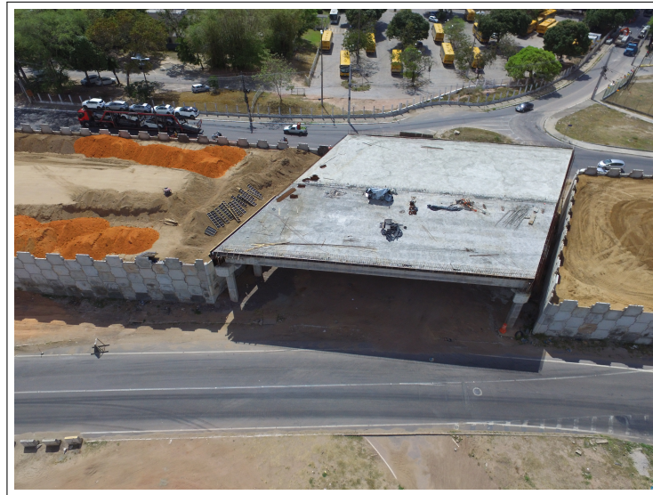
Figura 19 – Processo construtivo - Viaduto 2 - João Pessoa - Água Fria
