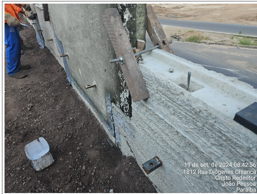
Figura 43 – Impermeabilização interna dos painéis
