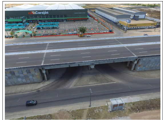
Figura 22 – Viaduto 4 - Portal do Poço
