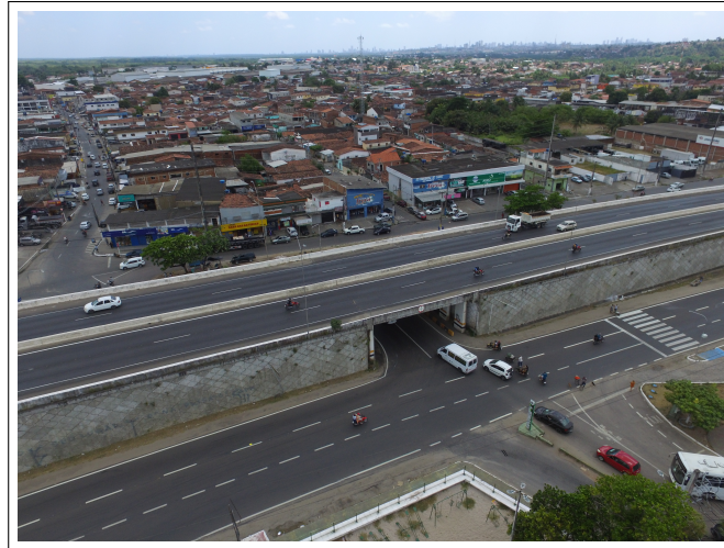
Figura 17 – Viaduto 1, Bayeux - Major Ciraulo
