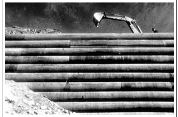
Figura 3 – Primeira estrutura de solo reforçado nos Pirenéus com painéis em U
