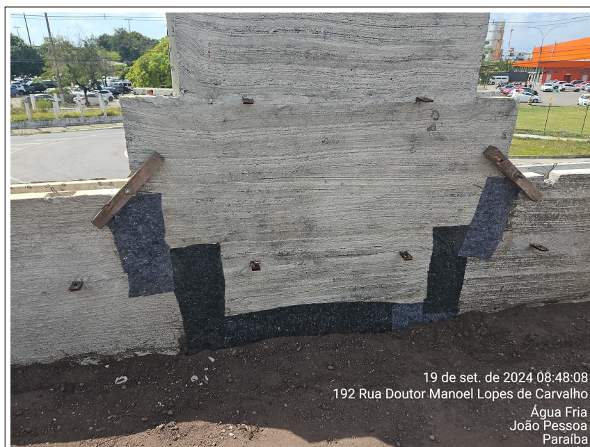
Figura 44 – Aplicação da manta de drenagem Bidim
