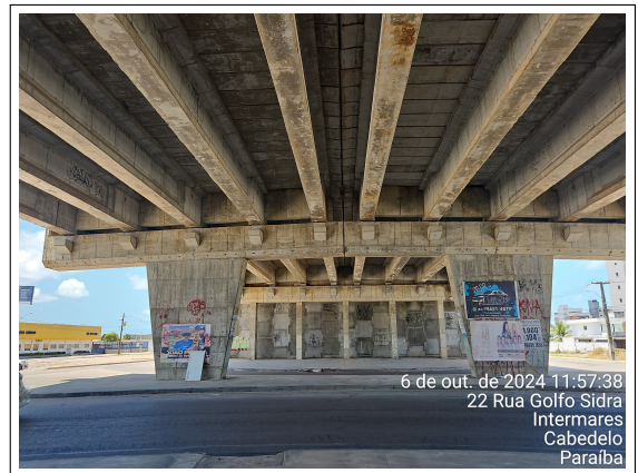
Figura 26 – Viaduto 4 - Portal do Poço
