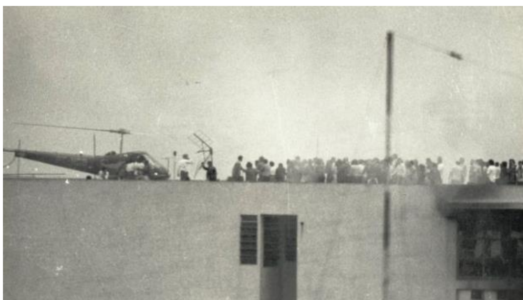
Figura 5 – Resgate no heliponto do edifício Andraus
