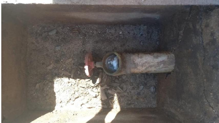
Figura 24 - Hidrante de passeio
