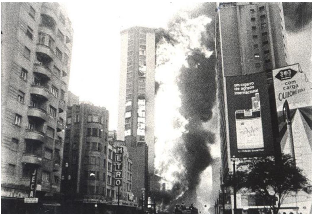
Figura 4 – Incêndio no edifício Andraus
