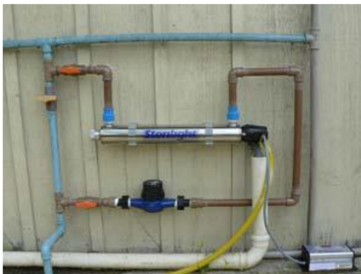
Figura 37 – Sistema com reator UV com câmara de aço inox
