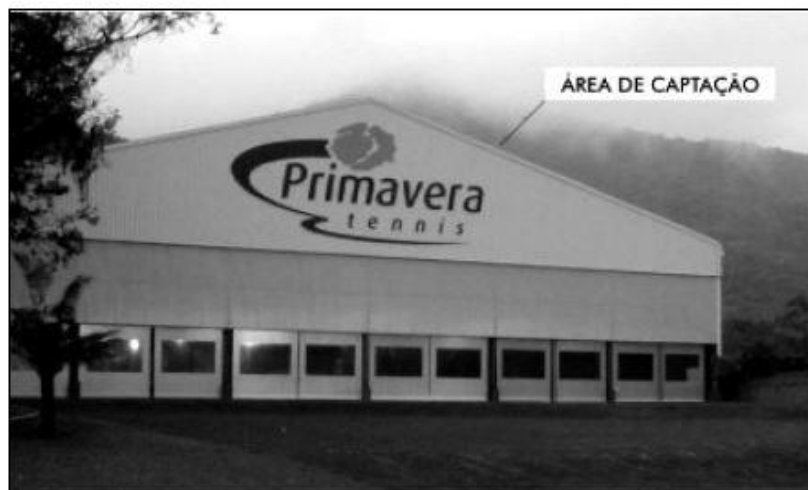
Figura 2 – Área de captação da quadra de tênis
