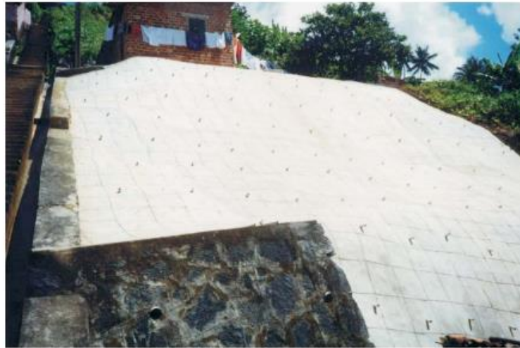
Figura 22 - revestimento com tela argamassada
