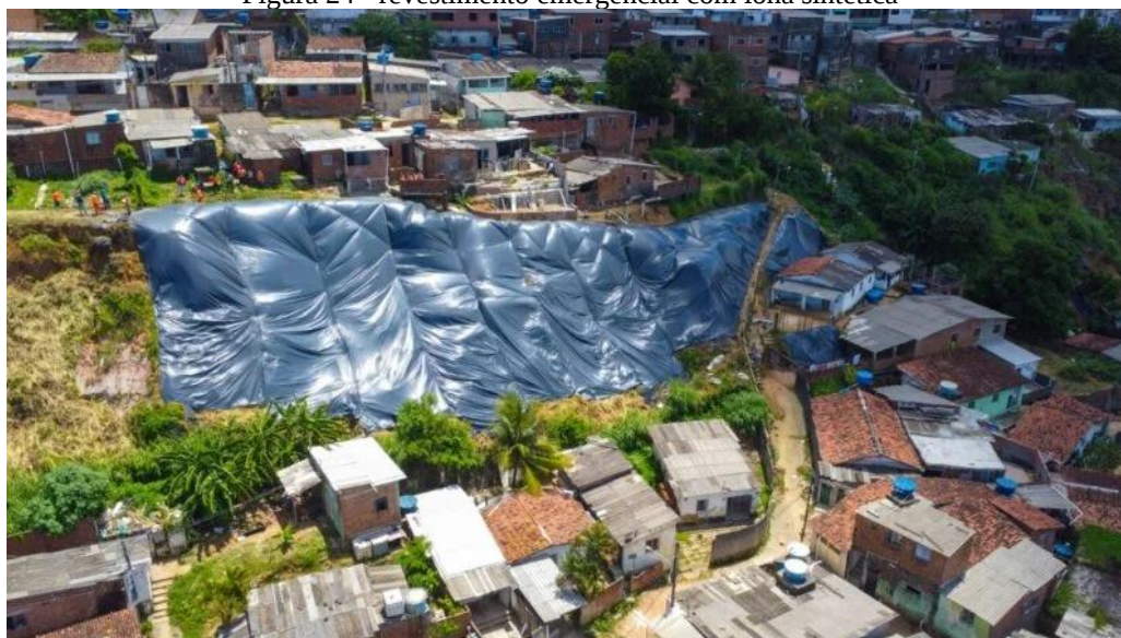
Figura 24 - revestimento emergencial com lona sintética
