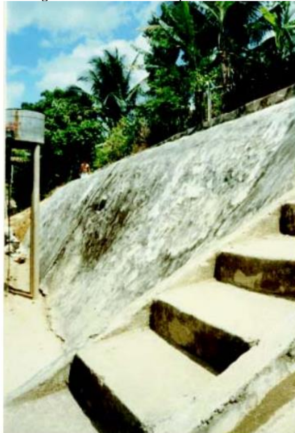
Figura 21 - revestimento superficial cimentado
