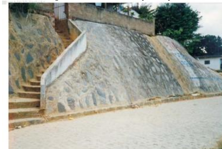
Figura 23 - revestimento com pano de pedra
