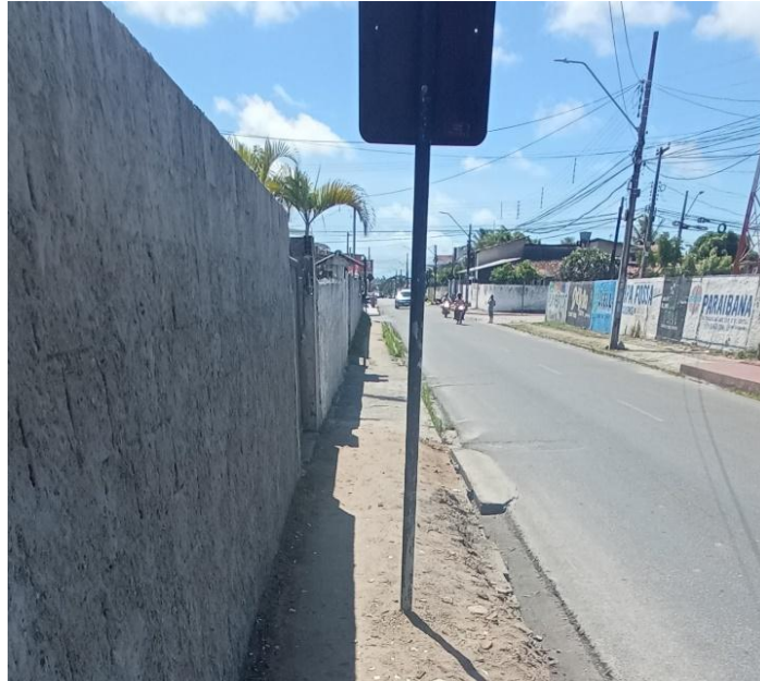
Figura 44: Ponto de ônibus em uma calçada no subtrecho D
