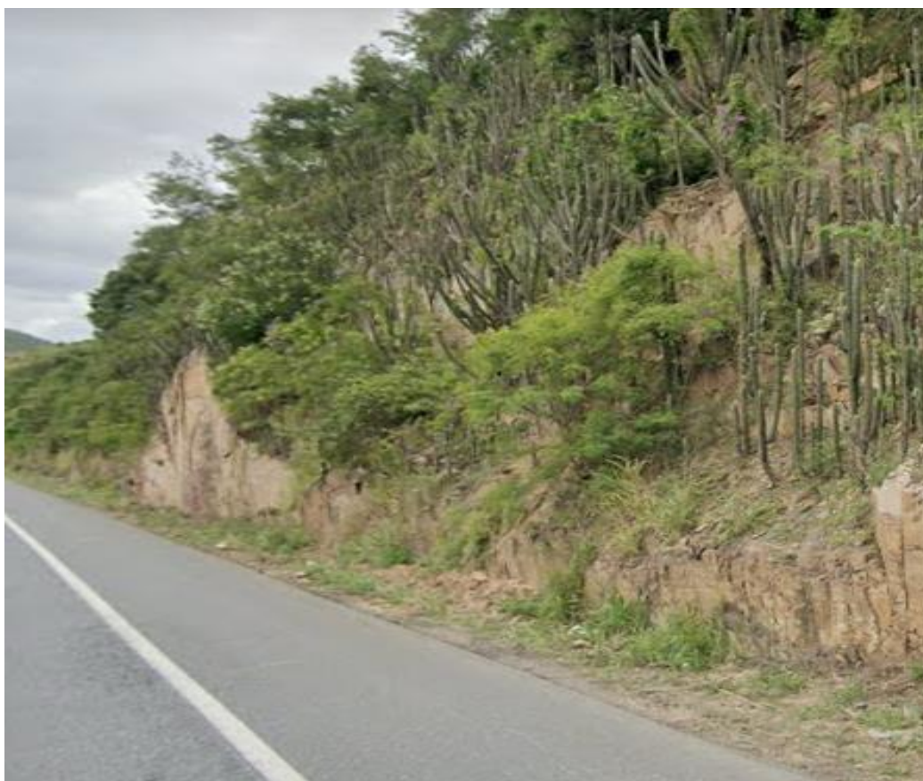
Figura 28: Talude rochoso com vegetação
