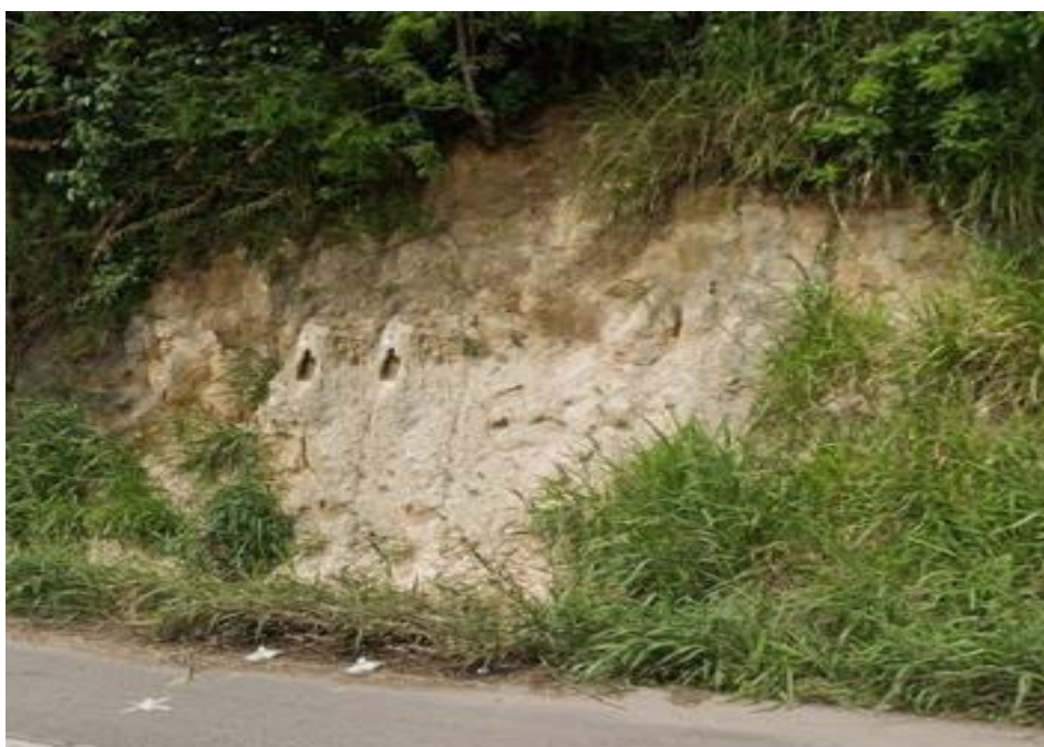
Figura 26: Talude de regossolo
