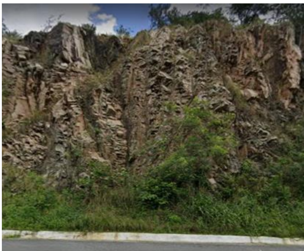
Figura 27: Talude rochoso na saída do túnel
