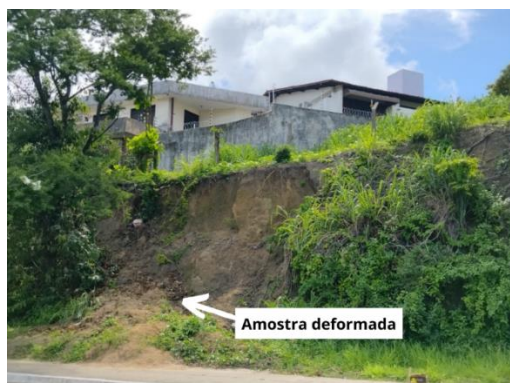
Figura 24 - Ponto do talude que foi retirado a amostra deformada
