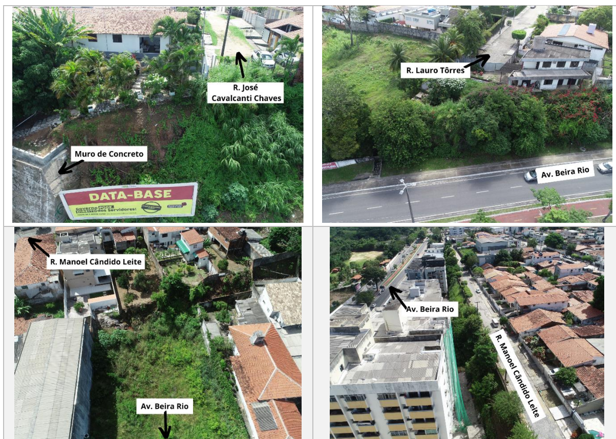
Figura 7 - Ocupações em volta do Talude em estudo
