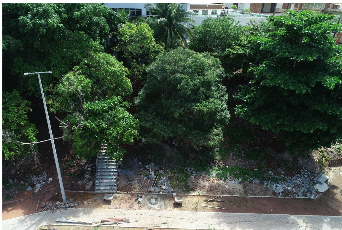
Figura 20 - Ponto 5. Talude sob o Edifício Boulevard Miramar
