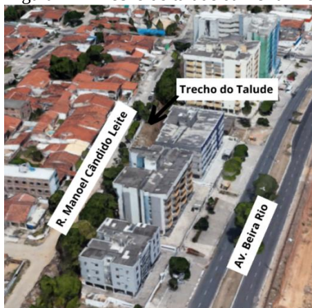
Figura 14 - Trecho do talude da Beira Rio
