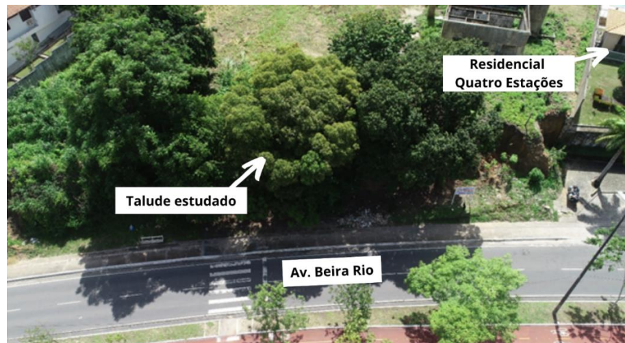
Figura 17 - Ponto 2. Zona do Talude estudado
