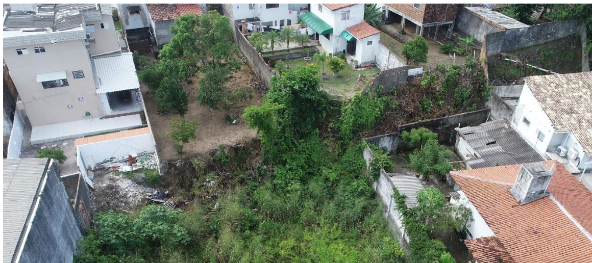
Figura 19 - Ponto 4. Recorte do Talude ao lado da TV Master
