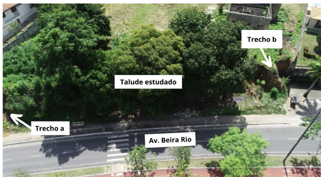
Figura 22 - Trechos do Talude analisado para parâmetros geotécnicos
