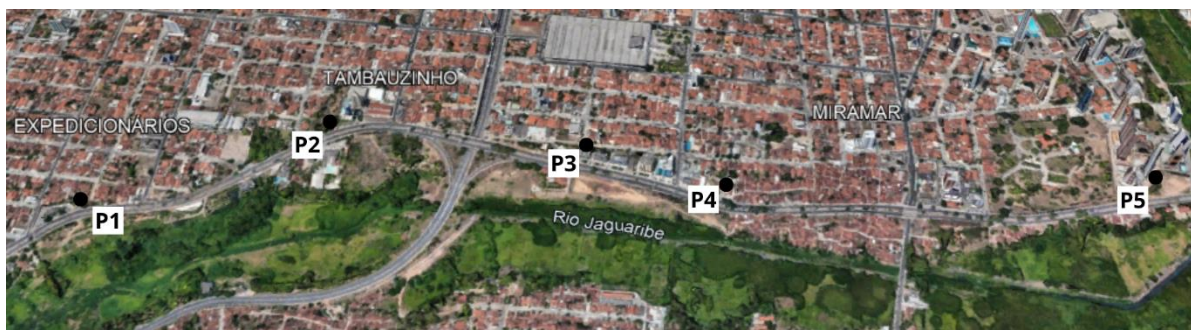
Figura 15 - Pontos críticos no talude da Av. Beira Rio
