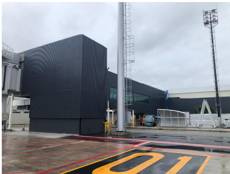
Figura 2- Parte fixa da ponte de embarque - visão externa
