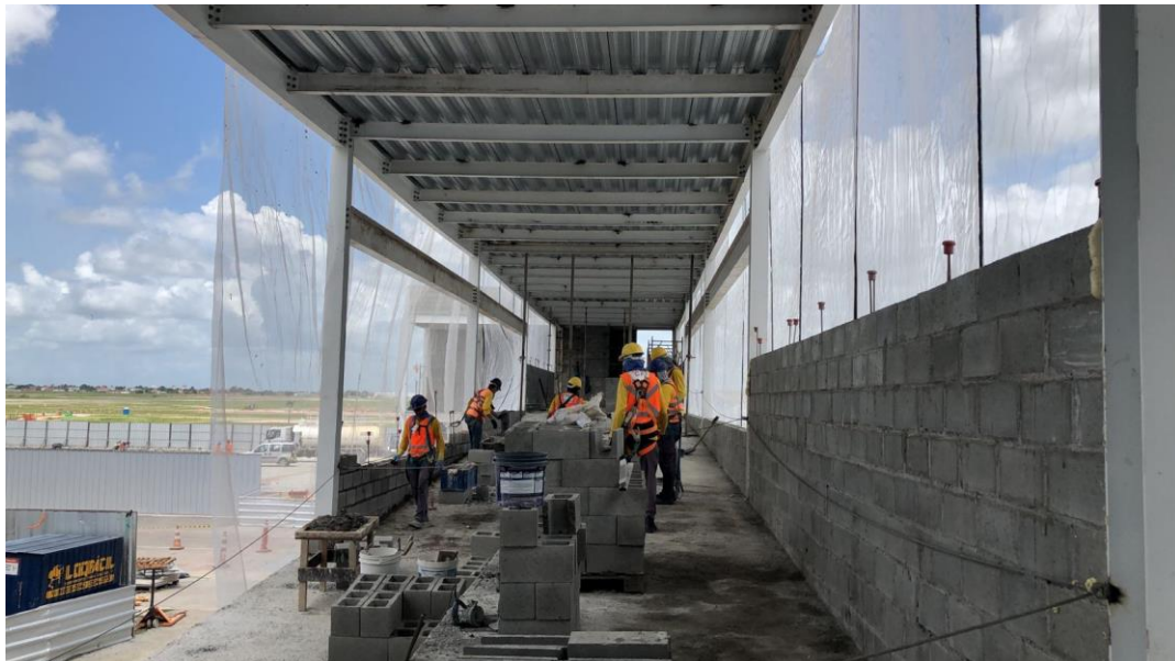
Figura 37- Elevação de alvenaria externa da Ponte de Embarque
