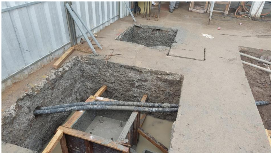
Figura 27- Concretagem dos pescoços das sapatas
