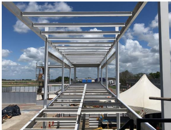
Figura 4- Montagem da estrutura metálica da Ponte de Embarque
