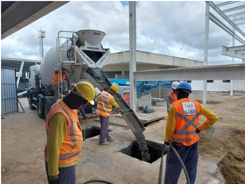
Figura 26- Concretagem de sapatas
