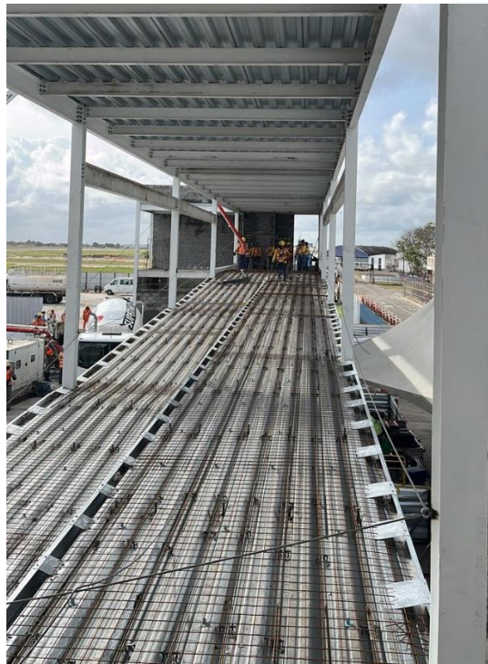
Figura 6- Armação do Steel deck da laje “Acesso” da Ponte de Embarque
