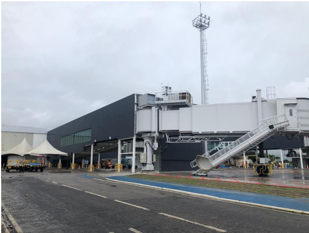
Figura 42- Ponte de embarque e Finger - visão externa
