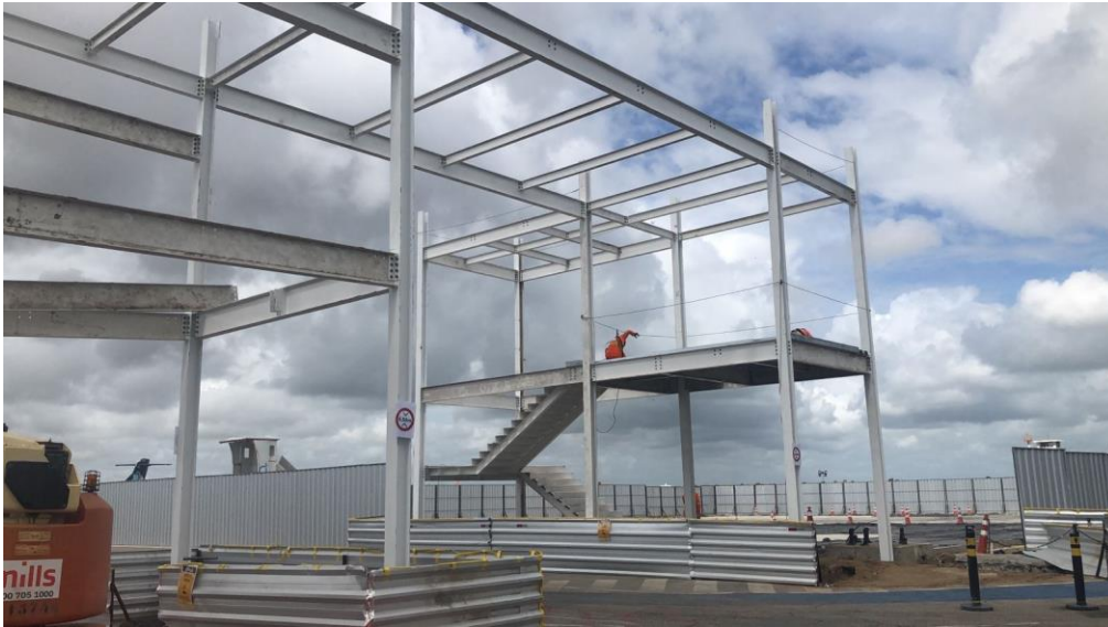
Figura 32-Montagem de estrutura metálica
