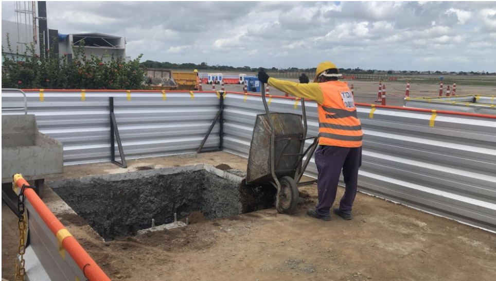
Figura 28- Reaterro de sapata
