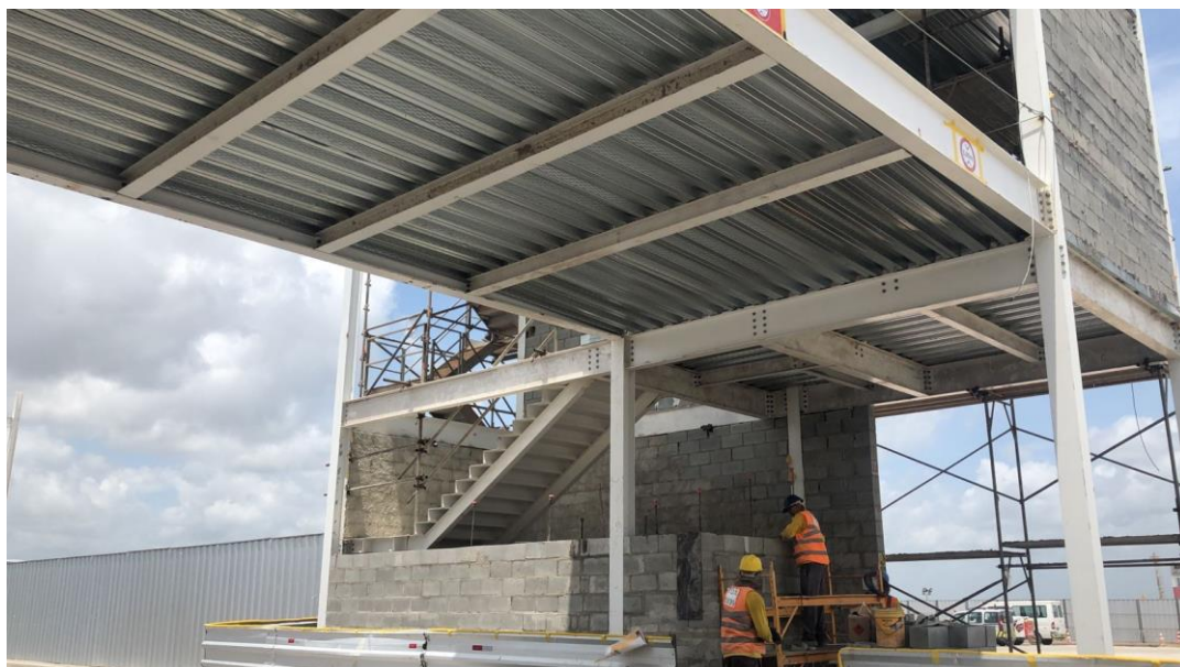
Figura 39-Elevação de alvenaria externa da Ponte de Embarque
