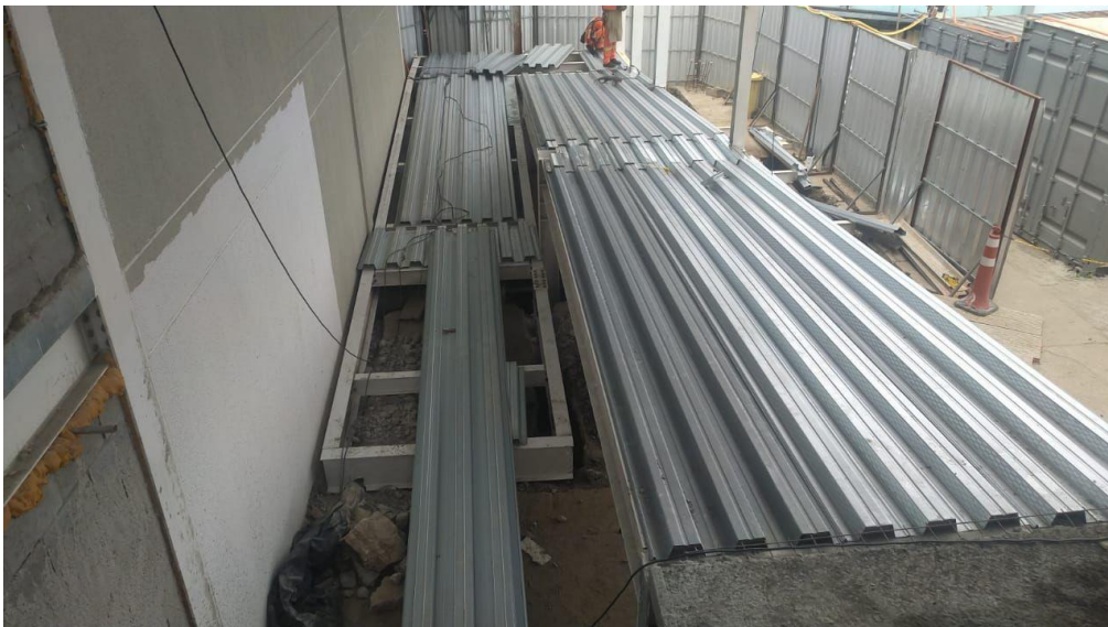
Figura 33- Montagem da laje Steel deck
