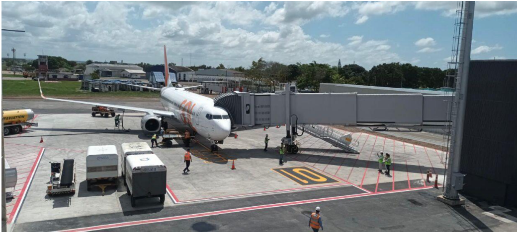
Figura 1- Avião acoplado no finger da ponte de embarque
