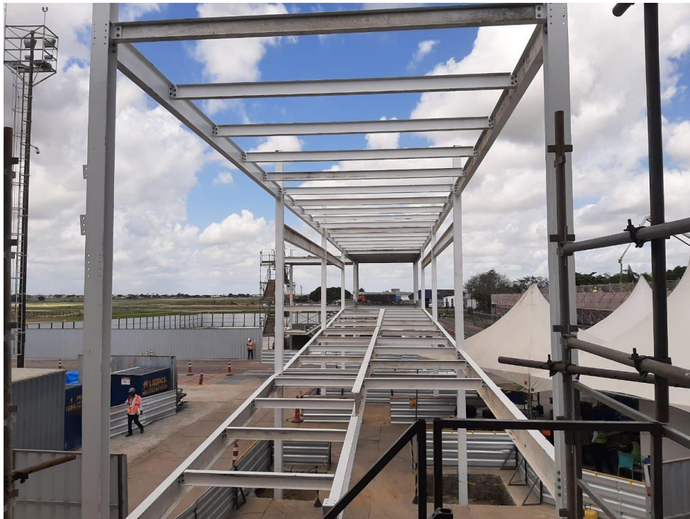
Figura 31- Montagem de estrutura metálica
