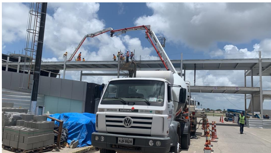
Figura 35- Concretagem da laje Steel deck
