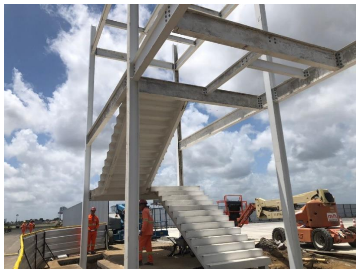
Figura 5- Montagem da escada metálica da Ponte de Embarque
