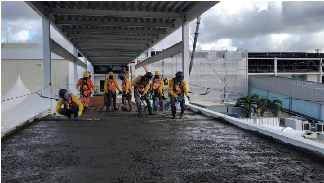
Figura 36- Concretagem da laje Steel deck
