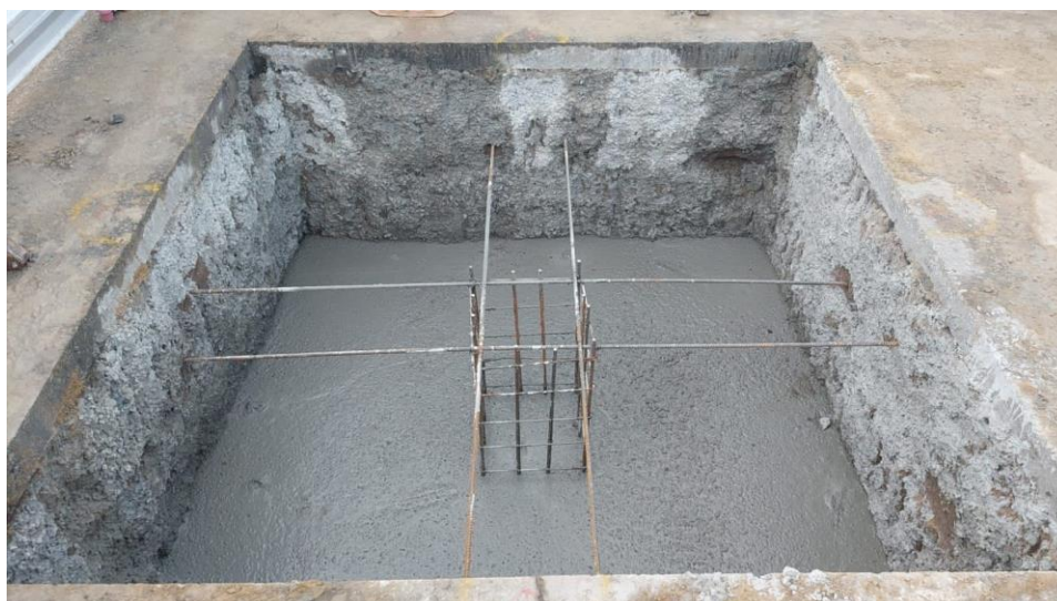
Figura 25- Concretagem de sapata
