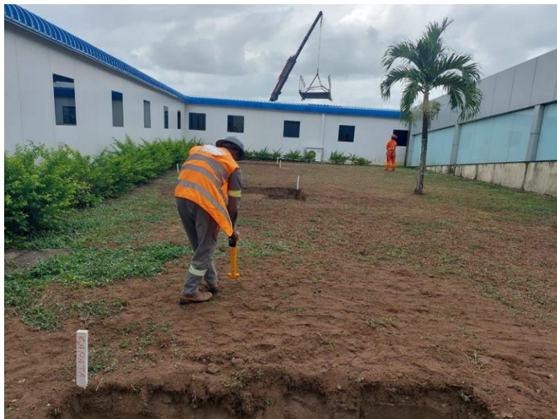
Figura 23- Utilização de Georadar para verificar a existência de tubulações existentes
