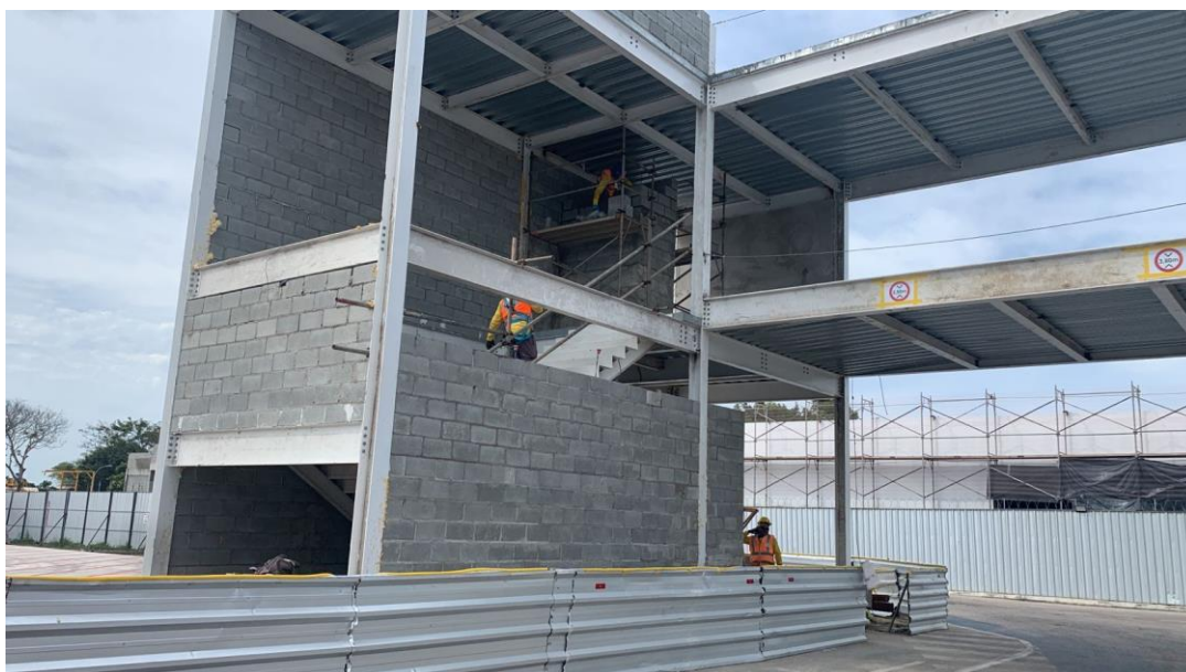
Figura 38- Elevação de alvenaria externa da Ponte de Embarque
