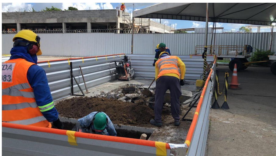
Figura 24- Escavação de sapatas
