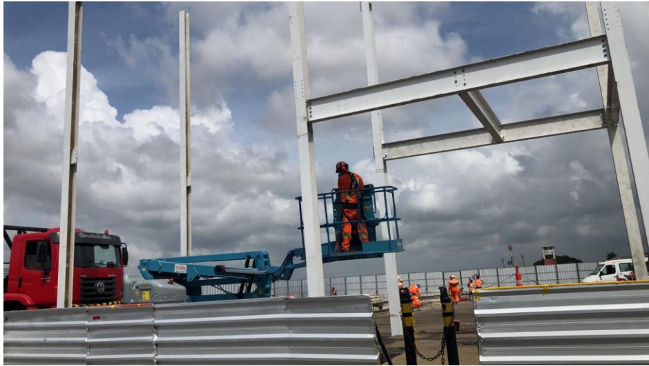
Figura 30- Montagem de pilares e vigas metálicas
