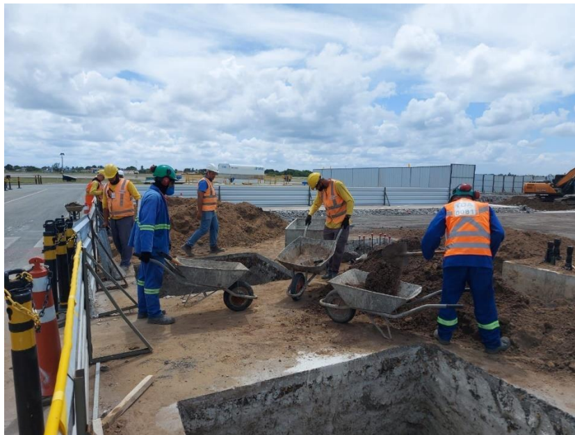
Figura 29- Reaterro de sapata
