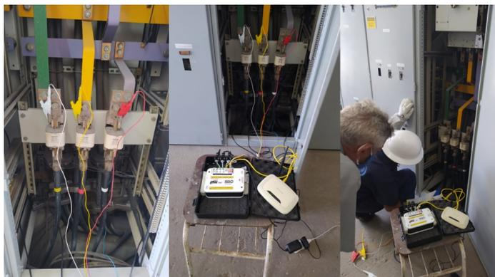
Figura 4.5 – Instalação do equipamento no Trafo 03.
