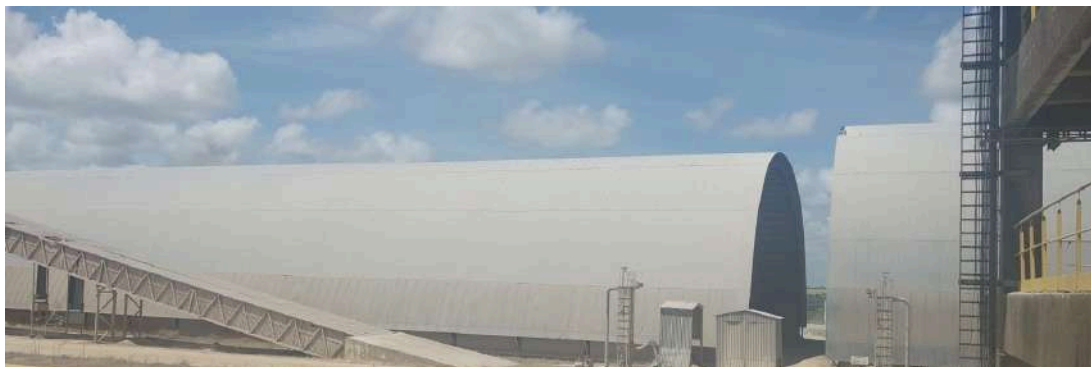
Figura 4 - Galpão para armazenamento de matéria-prima.
