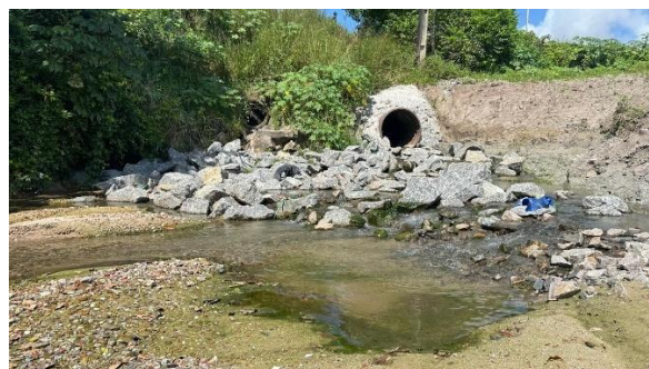
Figura 31: Resíduo sólido dentro do fluxo da drenagem (Ponto B).
