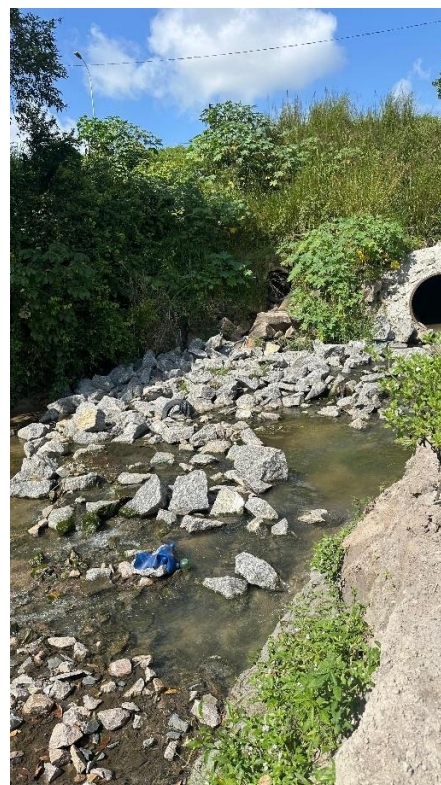
Figura 20: Tubulações de drenagem no Ponto B.
