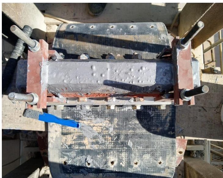
Imagem 07 – Aplicação da resina na caixa de emenda
