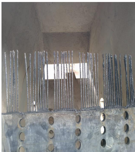
Imagem 05 – Limpeza dos cabos
