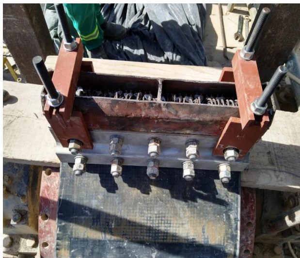
Imagem 06 – Montagem da caixa de emenda e da prensa
