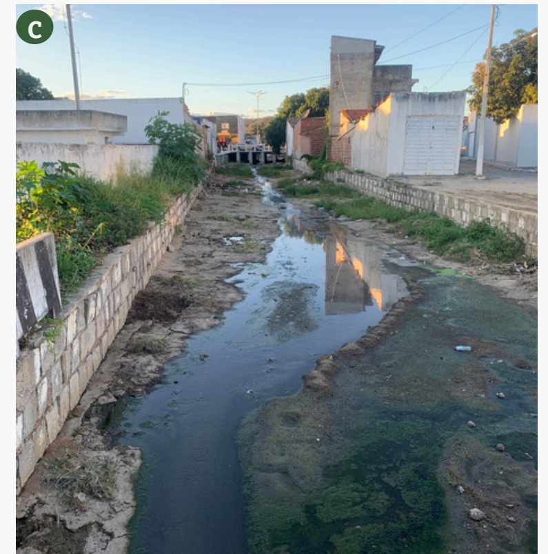
FIGURA 114: CANAL A CÉU ABERTO NO BAIRRO DO SANTO ANTONIO
