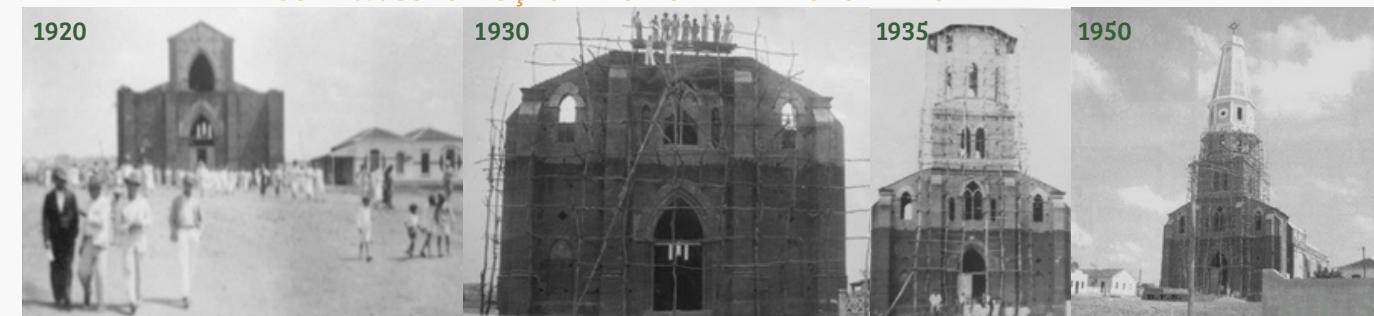
FIGURA 09: CONSTRUÇÃO DA IGREJA MATRIZ SÃO PEDRO EM ITAPETIM-PE
