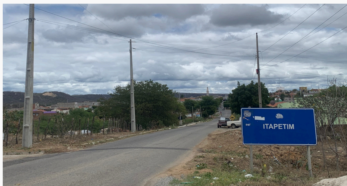
FIGURA 102: VIA ASFALTADA NO INÍCIO DO PERÍMETRO URBANO
