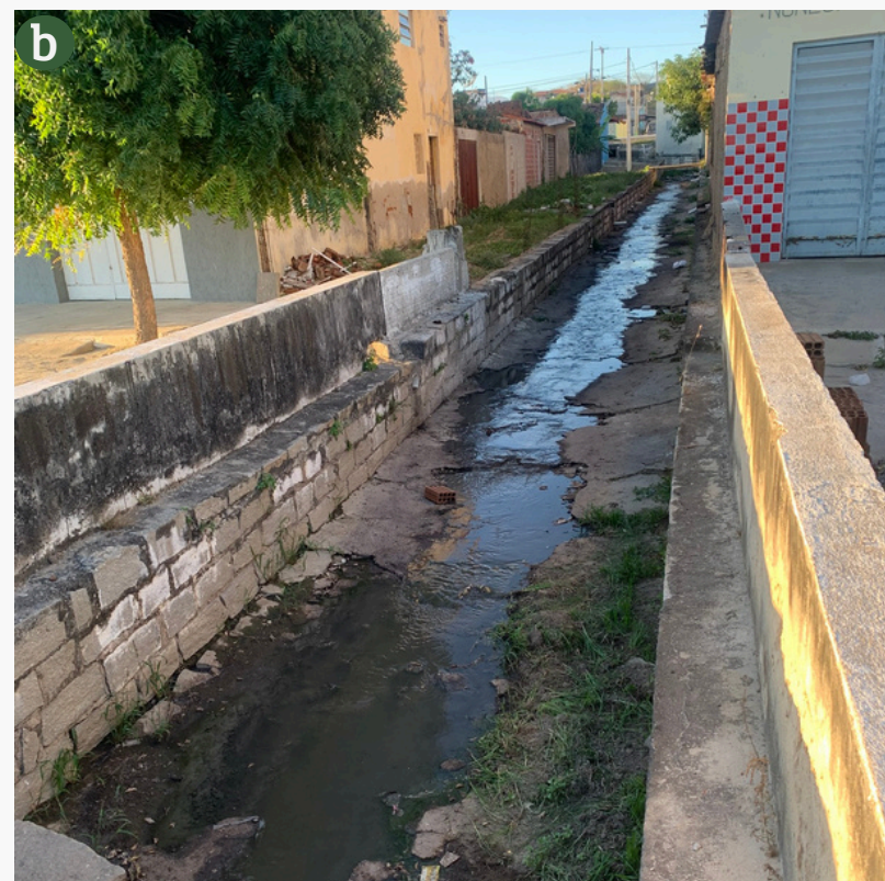
FIGURA 112: CANAL A CÉU ABERTO NO BAIRRO DO CENTRO
