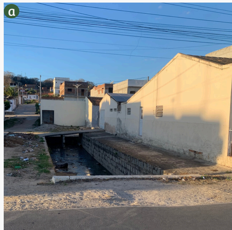
FIGURA 110: CANAL A CÉU ABERTO NO BAIRRO DO PAULO XI
