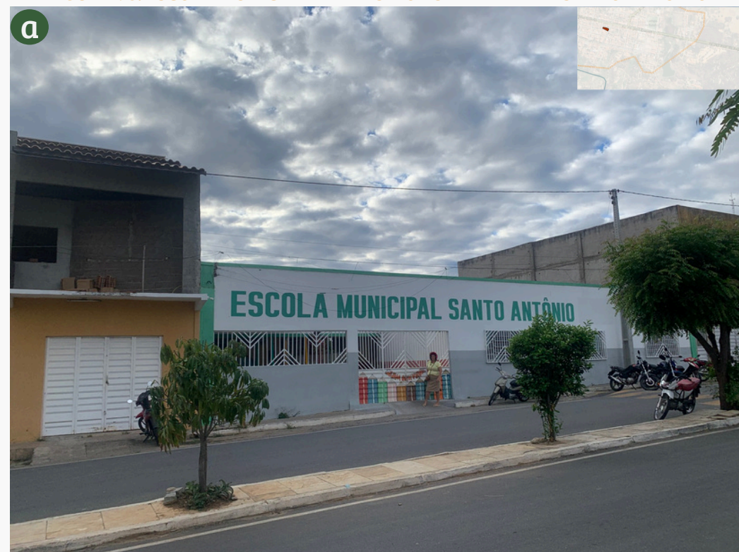
FIGURA 95: ESCOLA MUNICIPAL DE ENSINO FUNDAMENTAL SANTO ANTÔNIO
