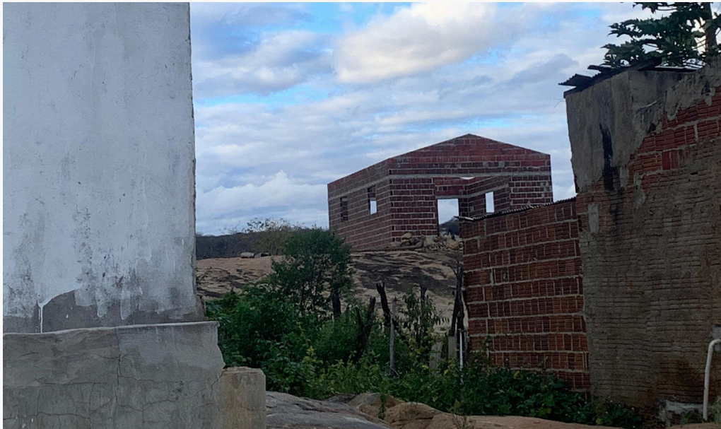
FIGURA 42: CONSTRUÇÃO EM TERRENO ROCHOSO
