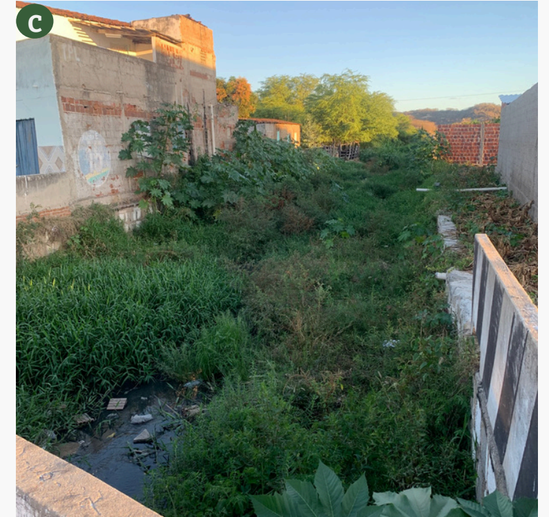
FIGURA 115: CANAL A CÉU ABERTO NO BAIRRO DO SANTO ANTONIO
