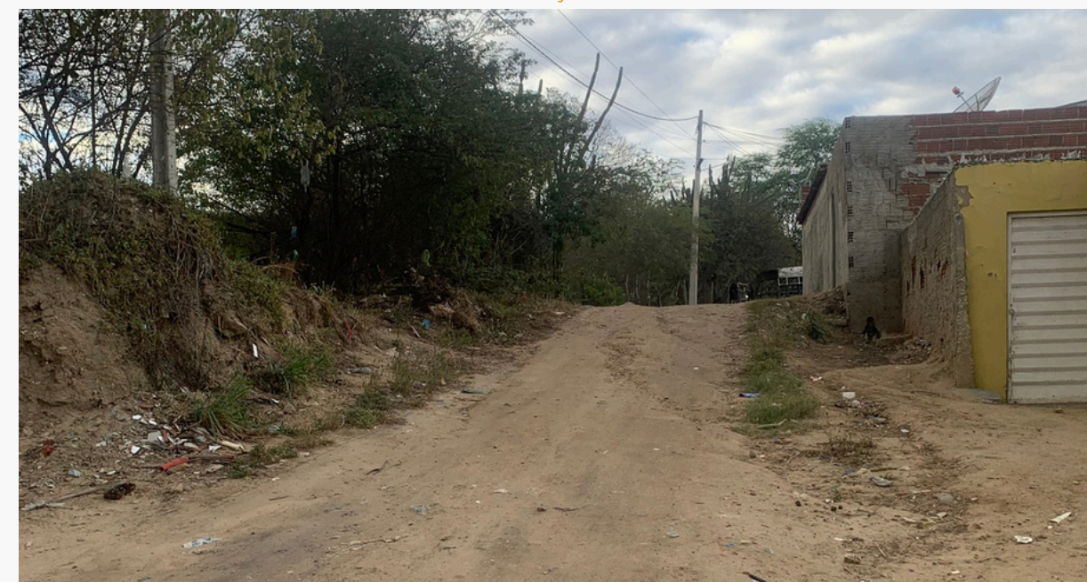
FIGURA 104: VIA SEM PAVIMENTAÇÃO EM ZONA PERIFÉRICA DA CIDADE
