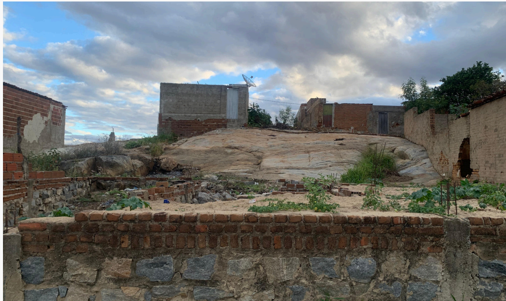
FIGURA 43: CONSTRUÇÃO EM TERRENO ROCHOSO
