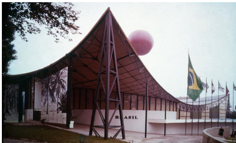
Figura 08: Pavilhão do Brasil em Bruxelas (1958), projeto de Sérgio Bernardes.
