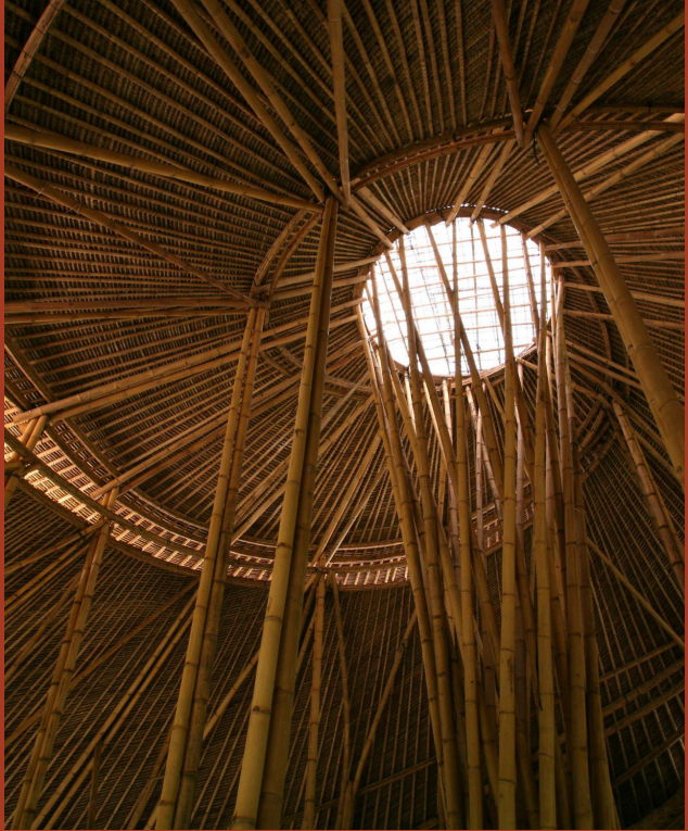
Figura: Estrutura de Bambu - The Green School.
