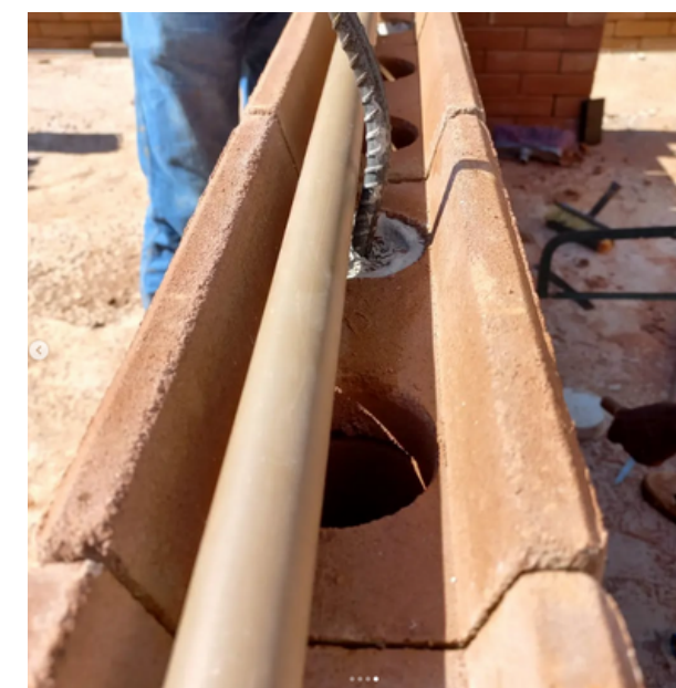
Figura 44: Passagem das instalações pelas canaletas. Fonte: E-leve, 2023.
