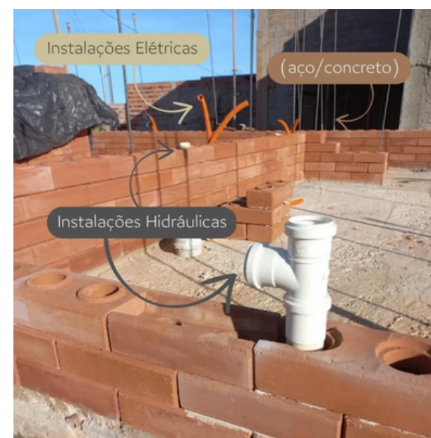
Figura 43: Passagem das instalações pelos furos. Fonte: E-leve, 2023.
