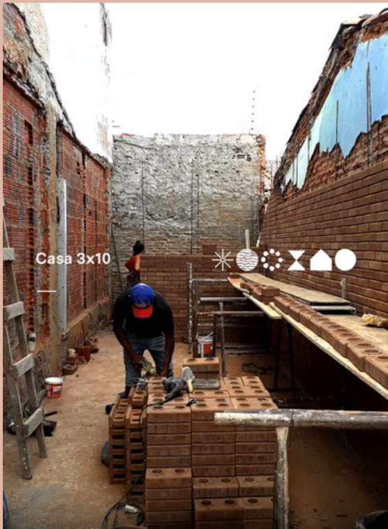
Figura 54: Construção Casa 3X10.
