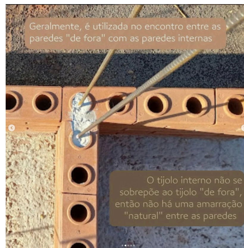
Figura 47: Graute dos encontros de parede. Fonte: E-leve, 2023.
