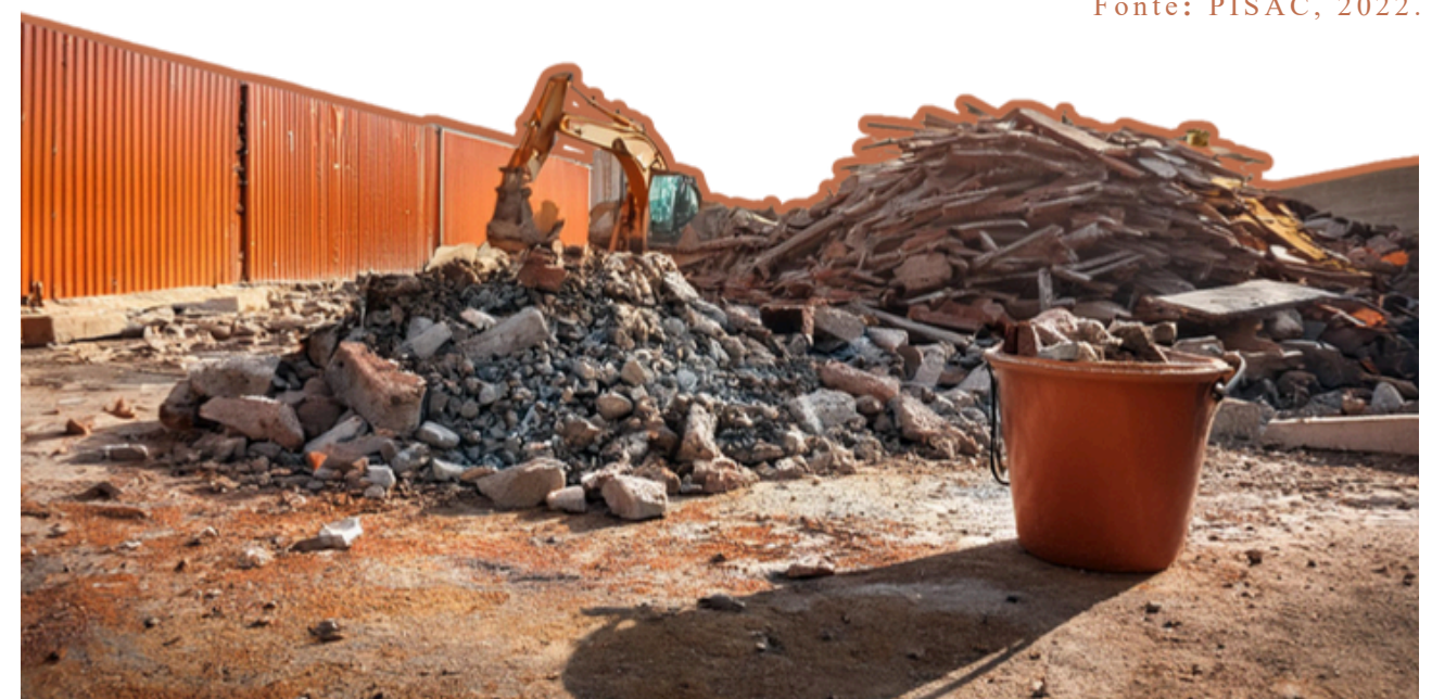
Figura 23: Colagem entulhos da construção civil. Fonte: PISAC, 2022.
