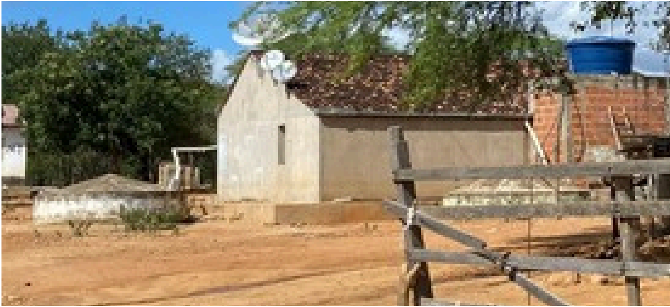
Figura 78: Cisternas para abastecimento da residência. Fonte: Elaborada pelo Autor, 2025.
