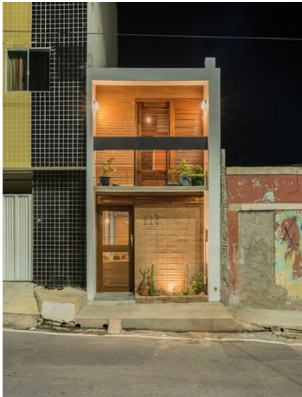
Figura 51: Fachada Casa 3x10.
