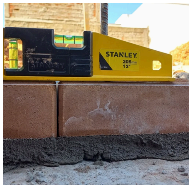
Figura 41: verificação do nível no acatamento da primeira fiada. Fonte: E-leve, 2023.
