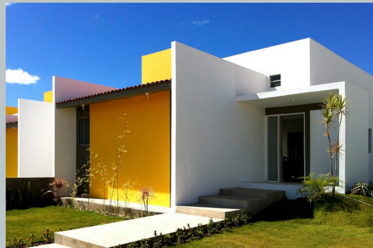
Figura 72: Vista externa da unidade habitacional da HIS Wirton Lira.
