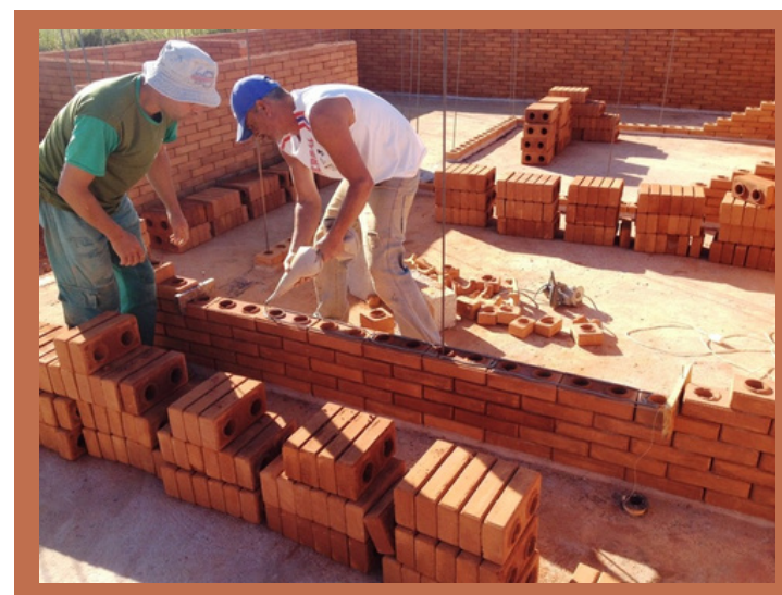
Figura 30: Assentamento dos tijolos.
