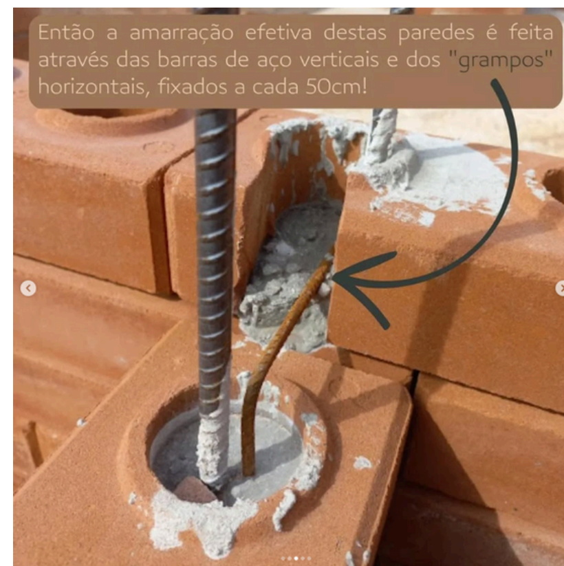
Figura 46: Esquema de amarração dos encontros de parede. Fonte: E-leve, 2023.
