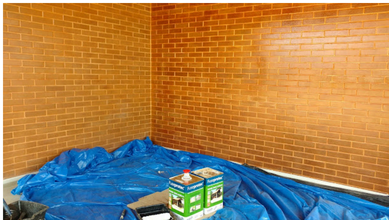
Figura 50: Tijolos com resina para impermeabilização. Fonte: Tijolos Solo Cimento, 2020
