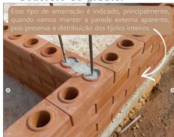
Figura 45: Grampos de amarração dos encontros de parede. Fonte: E-leve, 2023.
