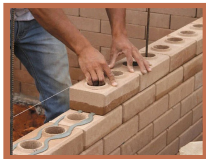
Figura 26: Redução de argamassa durante a construção. Fonte: Tijolo Brasil.
