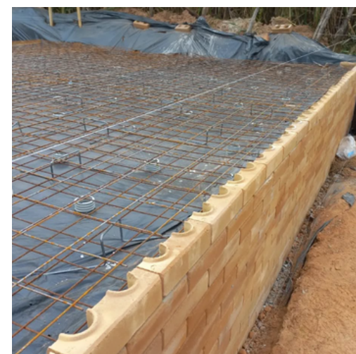
Figura 38: Muro de contenção para execução do radier. Fonte: E-leve, 2023.
