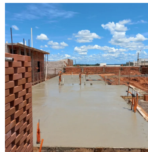
Figura 40: Concretagem do radier. Fonte: E-leve, 2023.
