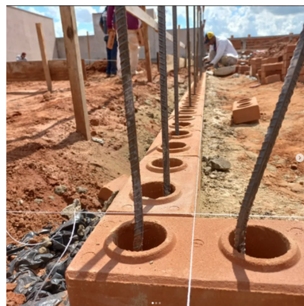
Figura 42: Marcação dos ferros para colunas. Fonte: E-leve, 2023.
